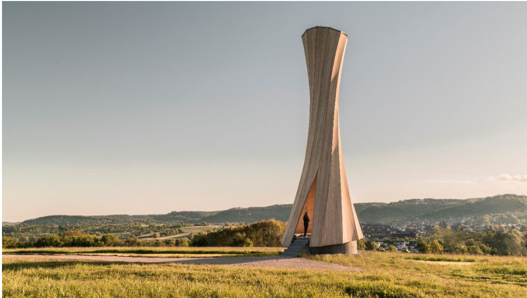
Abbildung 13: Die fertige Struktur des Urbach Turms, eine Hochleistungs-Holzkonstruktion aus selbstgeformtem, gebogenen Brettspertholz.
