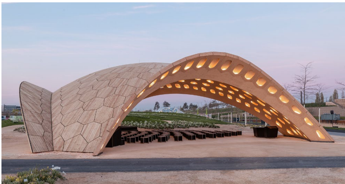
Abbildung 7: Der BUGA Holzpavillon spannt 30m frei über eine flexible Veranstaltungsfläche auf der Bundesgartenschau 2019 in Heilbronn.
