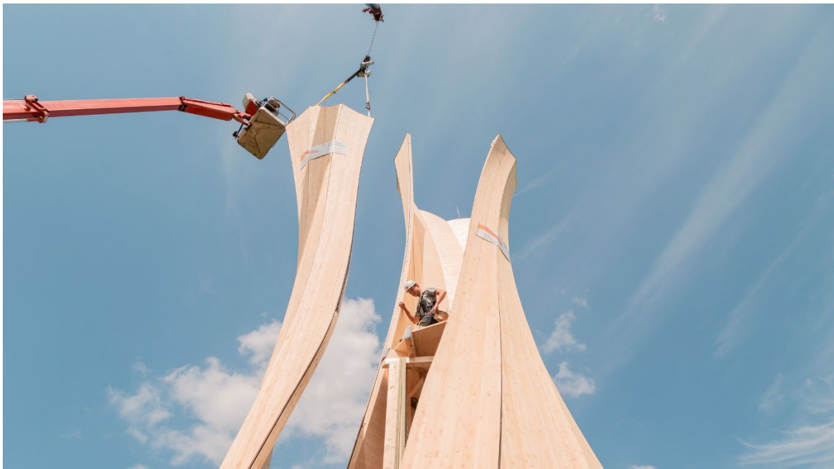
Abbildung 15: Montage der dünn-schaligen, gebogenen Komponenten des Turms vor Ort.
