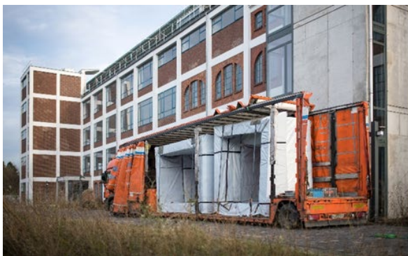
Abbildung 6: Neben den Elementverbindungen wurde auch der Transport und die Montage von Gebäudemodulen berücksichtigt
