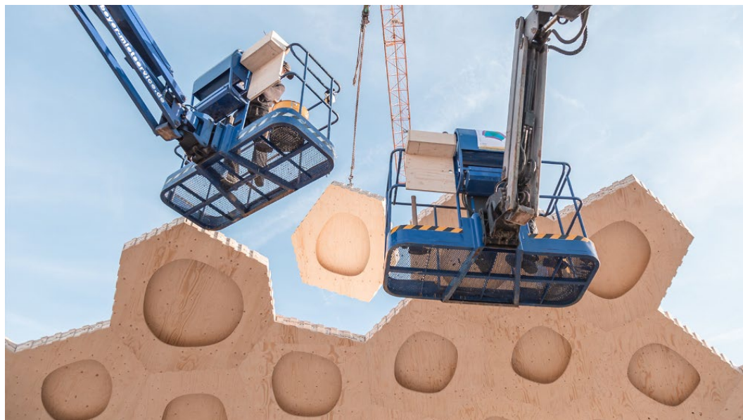
Abbildung 12: Aufbau der Hohlkassetten-Segmentschale im freien Vorbau.
