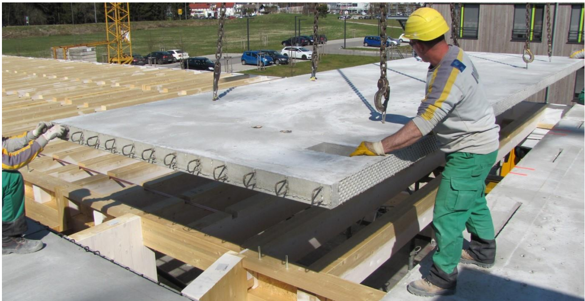
Abbildung 3: Montage Betonfertigteil auf Balkenlage
