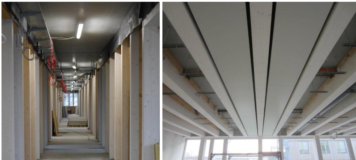
Abbildung 4: Flur ohne Deckenbalken mit Raum zur Installation | Deckenansicht mit Heiz-/ Kühlelementen zwischen der Balkenlage
