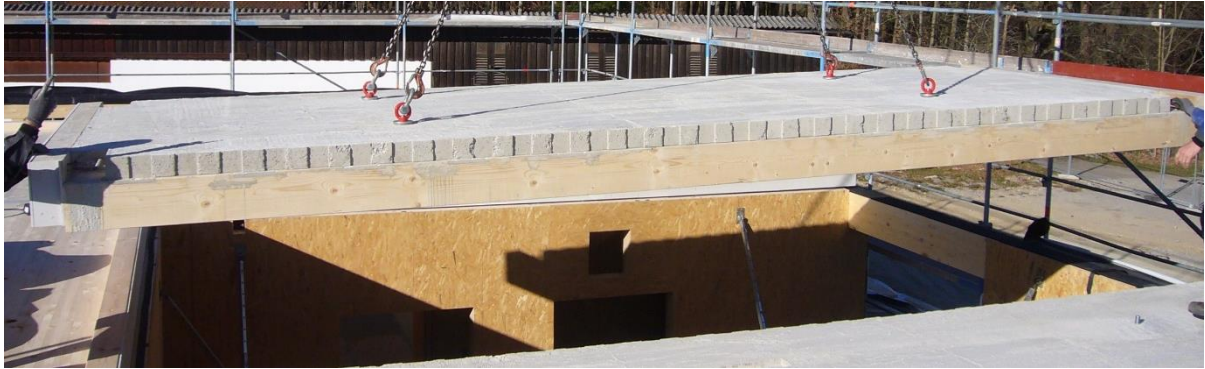
Abbildung 7: Montage der HBV-Decke als Vollfertigteil
