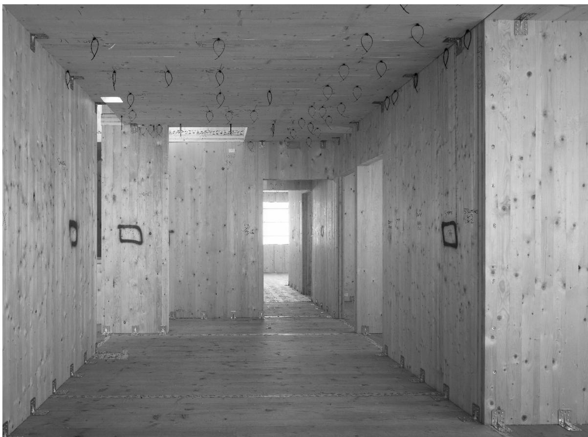
Figura 3: Murray Grove dettaglio della struttura in Xlam in fase di costruzione (© Will Pryce)
