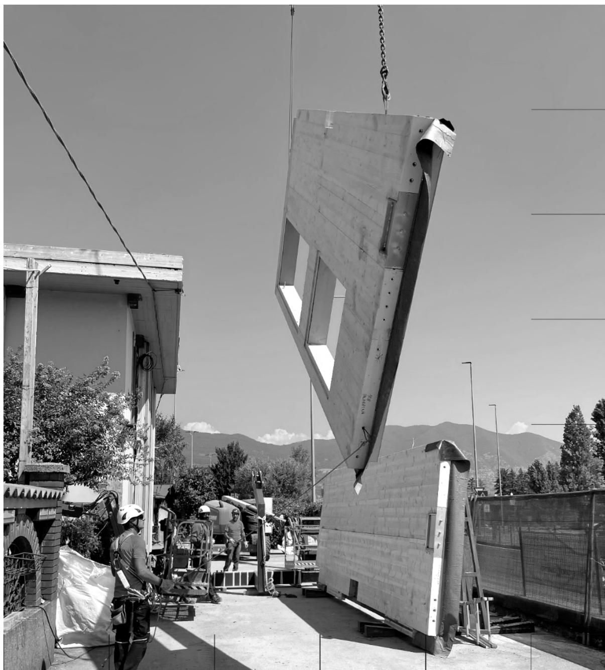
Figura 9: movimentazione di un pannello di facciata integrato prodotto off-site per il primo progetto pilota Energiesprong realizzato a Corte Franca (BS).
