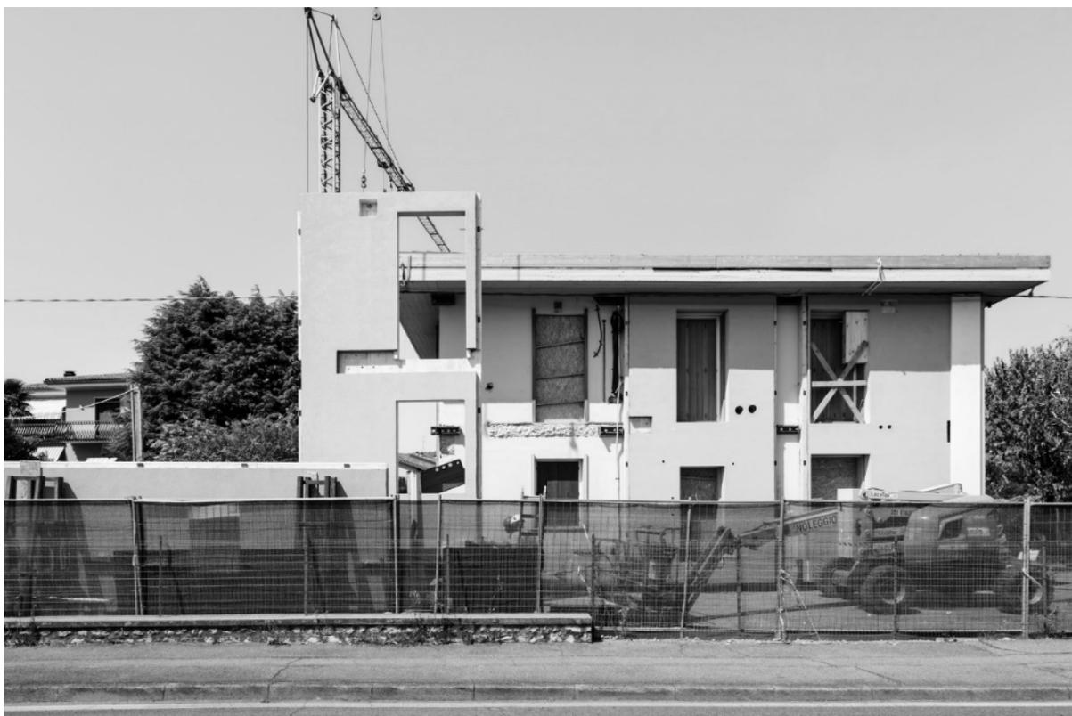
Figura 2: fasi di montaggio dei pannelli prodotti off-site
