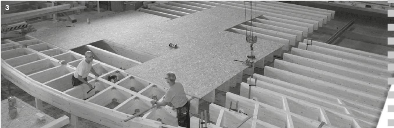
3 / Ristorante: solaio alto 40 cm con trave curvata e spazio lasciato per il travicello sull'impianto tectofix 3000
