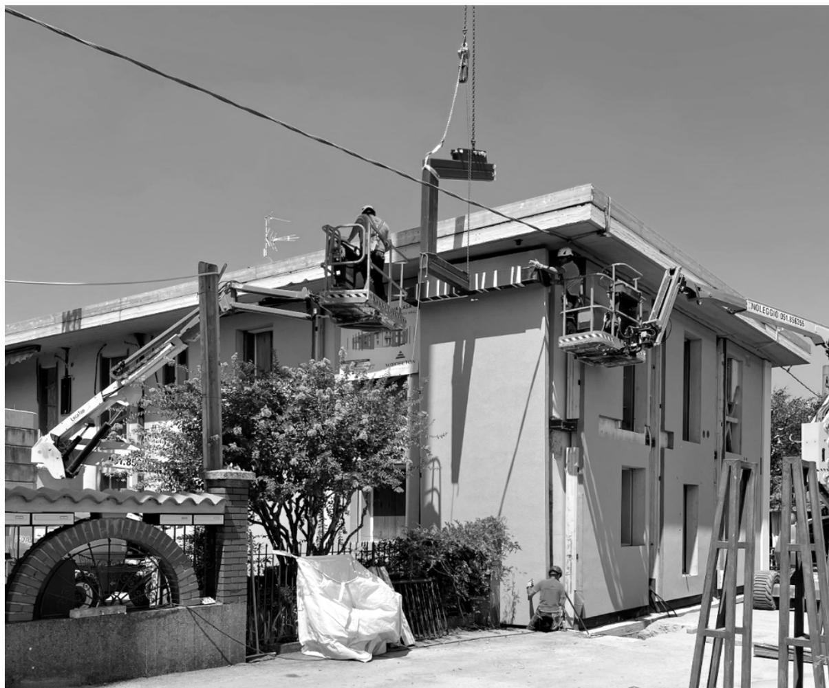
Figura 7: le fasi di installazione dei pannelli prefabbricati in legno a Corte Franca (BS)
