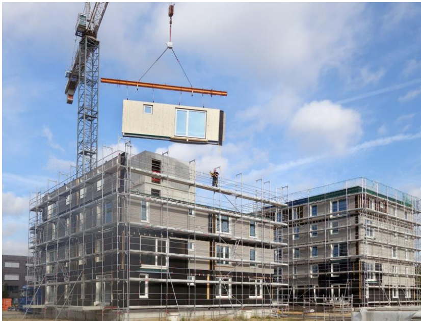
Abbildung 7: Montage Brettsper Holz
