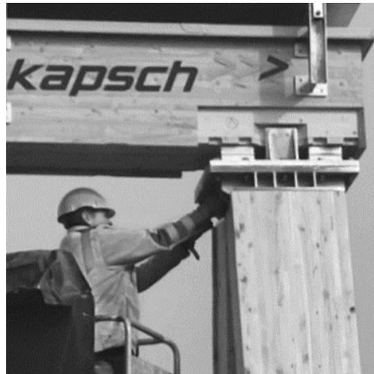
Abbildung 4: Biegesteifer Anschluss (Plandarstellung ohne konstruktiven Holzschutz)
