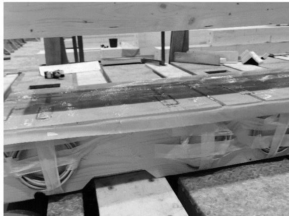
b) Blockverklebung des Riegels
