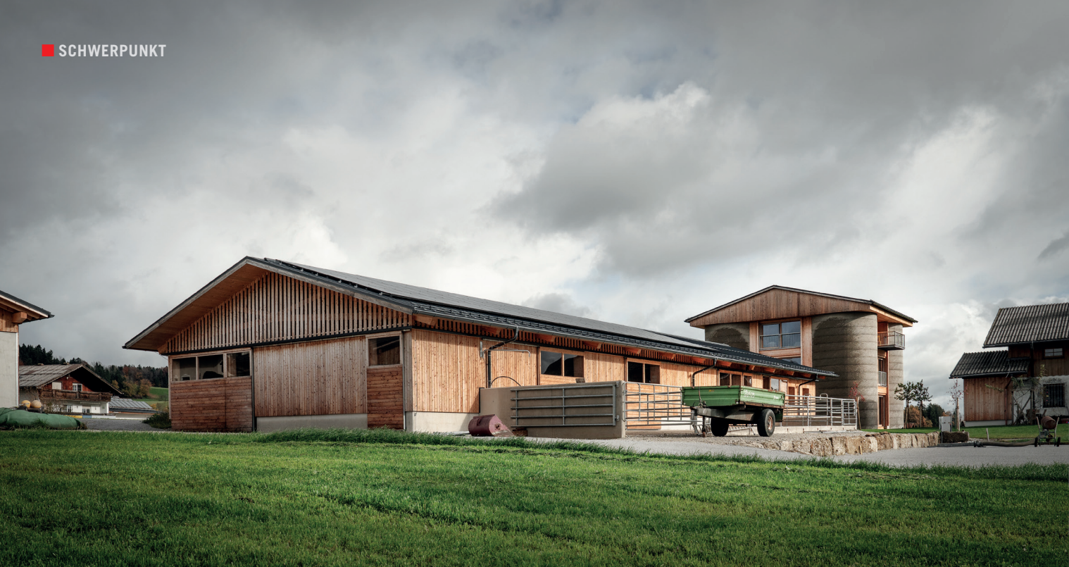
Neben der Umnutzung der Betonsilos entstand auch ein neuer Stall- und Wirtschaftstrakt, der die landwirtschaftliche Nutzung des Hofes zeitgemäß weiterführt.
