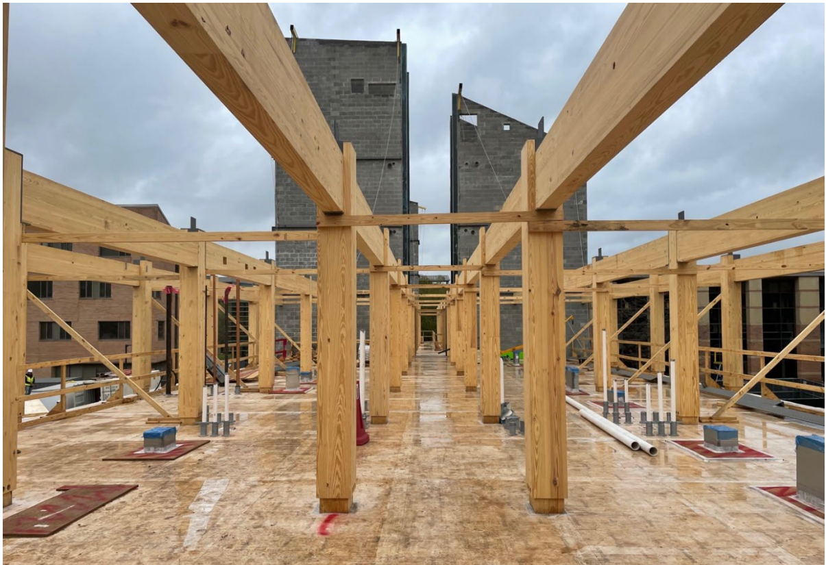
Abbildung 8: Foto Baustelle, CLT Stützen und Träger, Kerne aus Mauerwerk (CMU Blocks)
