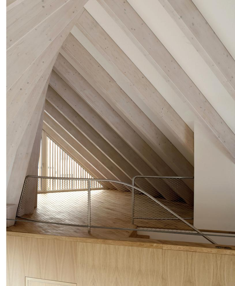
Die parallel angeordneten Sparren verlaufen linear von der zentralen Firstachse zu den beiden S-förmigen Traufkanten. Die einfach gekrümmten Dachflächen, deren Neigung gegenläufig von 40 Grad bis zur Senkrechten ansteigt, eignen sich ideal für ein Schilfdach.
