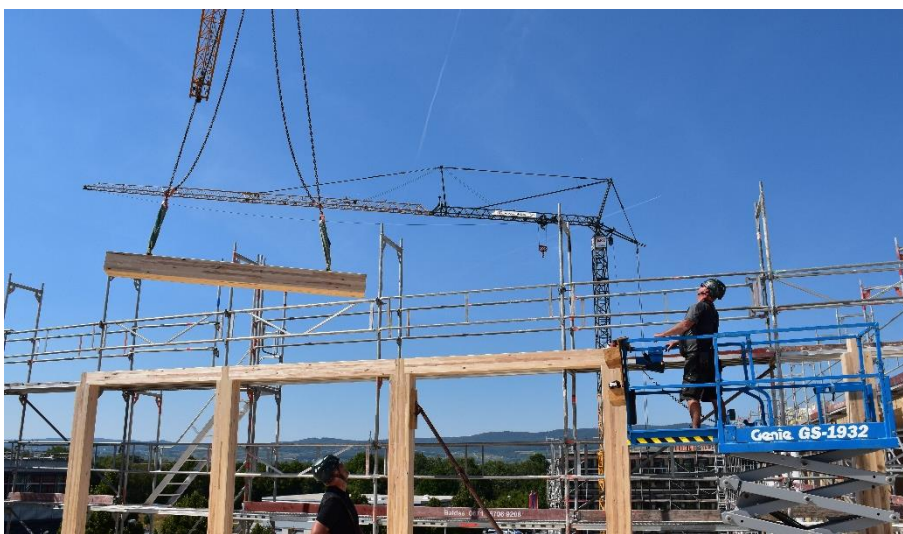
Abbildung 9: Hoher Vorfertigungsgrad, kurze Bauzeit, Rückbaubarkeit: Der Neubau in Ingelheim ist ein Leuchtturmprojekt in Sachen Innovation und Nachhaltigkeit (Foto: Fast + Epp, mit freundlicher Genehmigung des Landkreises Mainz-Bingen)
