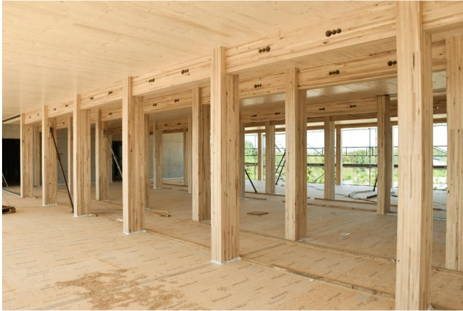
Abbildung 8: Die Holz-Skelettkonstruktion im Rohbau. Stützen und Unterzüge bestehen aus Birkenholz, die CLT-Deckenelemente aus Fichtenholz (Foto: Fast + Epp, mit freundlicher Genehmigung des Landkreises Mainz-Bingen)
