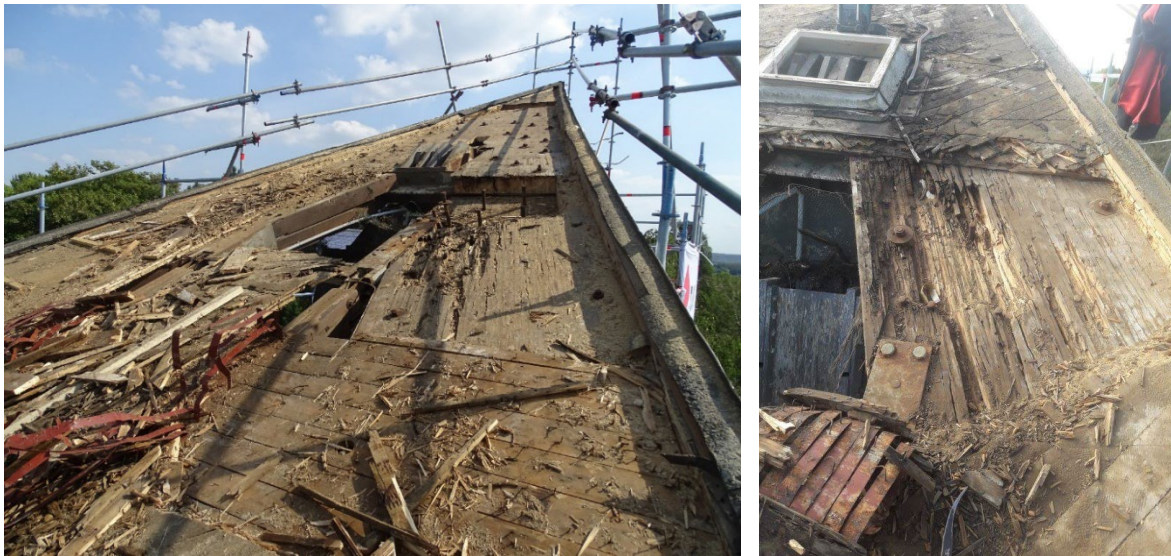
Abbildung 14: Ansicht des Hochpunktes H1 mit großflächiger Fäulnisschädigung
