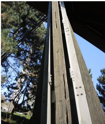
Abbildung 7: geschädigte Brettschichtholzstütze mit Stahlkorsett
