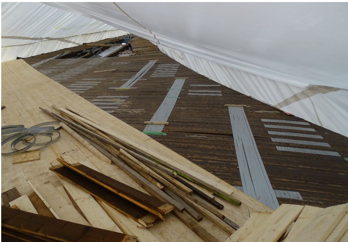
Abbildung 17: Ansicht der Erneuerung der dreilagigen Holzschalung mit zugfester Längsstoßausbildung an den Lamellen der unteren Lage.
