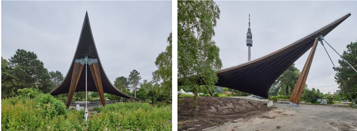
Abbildung 18: Ansicht der erneuerten Stützenkonstruktionen (Stützen und Spannseile erneuert, Stahlschlussteile renoviert) am Hochpunkt H2 mit 2 Stützen und einem Spannseil und am Hochpunkt H1 mit einer Stütze und zwei Spannseilen nach Abschluss der Sanierungsarbeiten (Bilder: Landes / Wüstenrot Stiftung)
