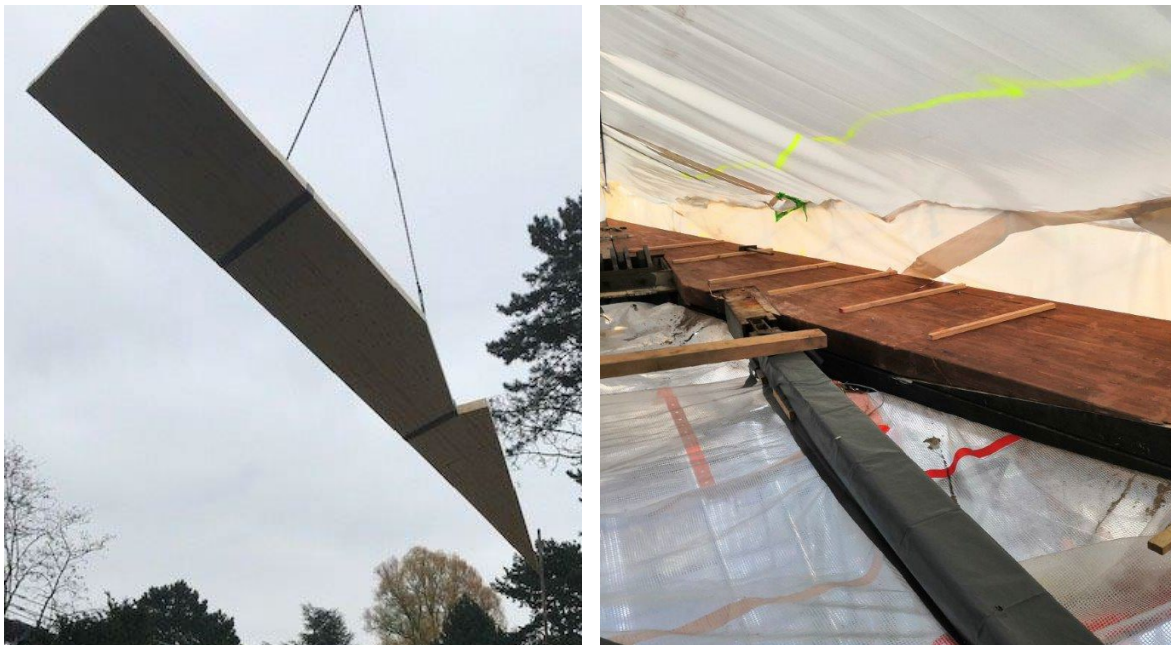
Abbildung 15: Ansicht der im Werk vorgefertigten Prothese, die mittels Schäftung angeklebt wurde
