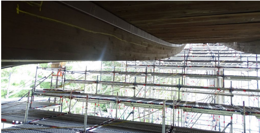
Abbildung 11: Untersicht des Sonnensegels mit Flächengerüst zur Rissverpressung an Nebenträgern
