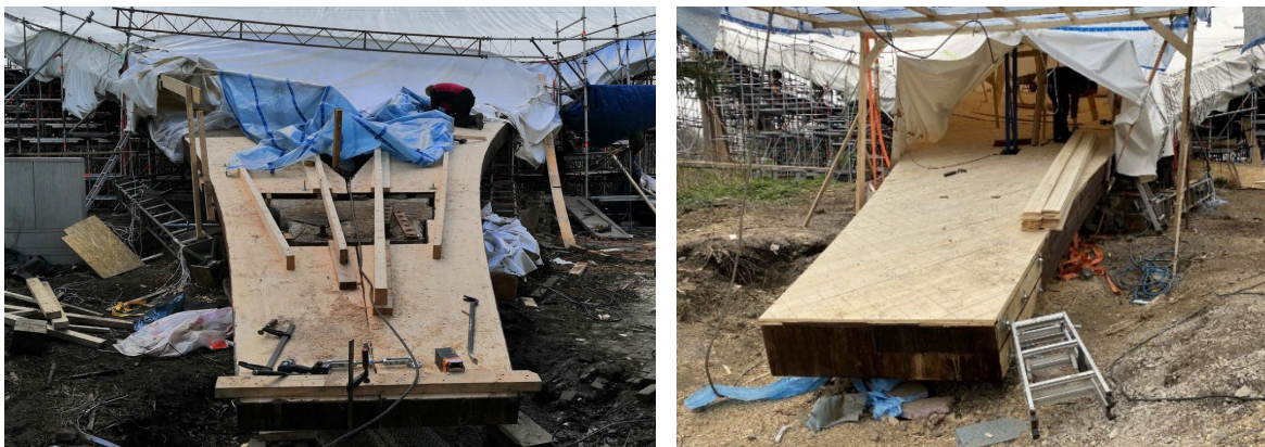
Abbildung 13: Ansicht des Tiefpunktes T1 mit angepassten Prothesen und final bereits mit Holzschalung
