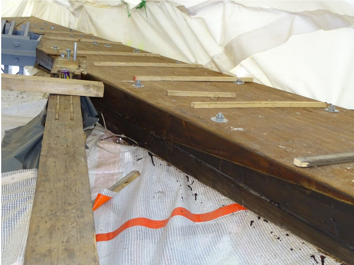
Abbildung 16: Ansicht der vollständig eingebauten, mit der unteren Querschnittshälfte des Randträgers verbolzten Prothese am Hochpunkt H1
