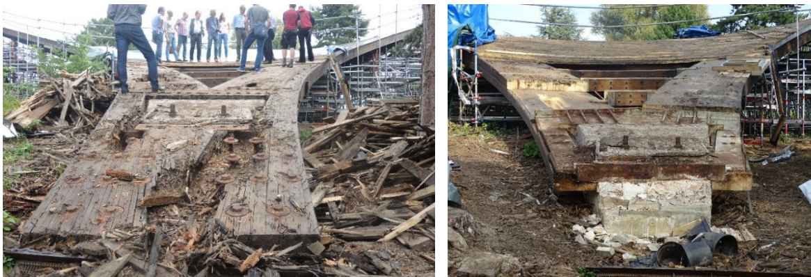
Abbildung 12: Ansicht der Schädigung am Tiefpunkt T1 und nach Entfernen der schadhaften Bereiche
