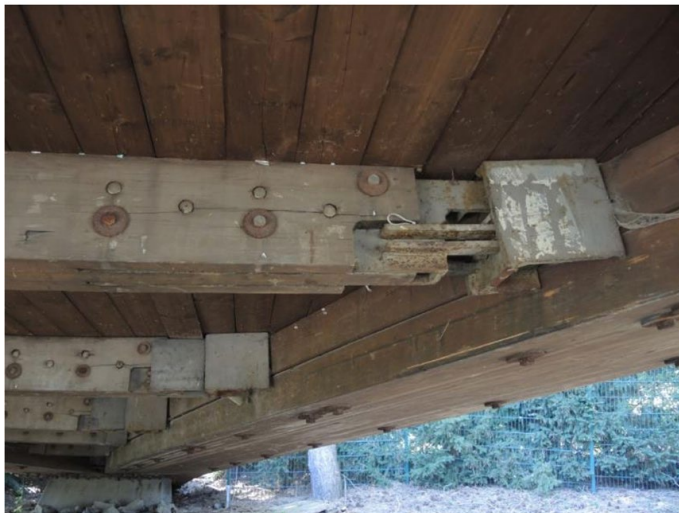
Abbildung 5: Ansicht eines Nebenträger-Randträger-Anschlusses
