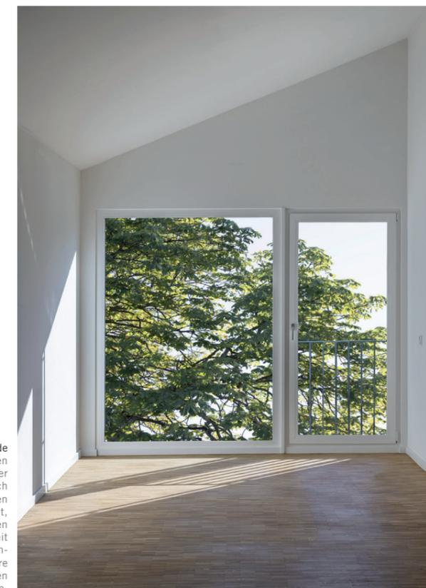
Die raumseitigen Wände sind mit Gipsplatten beplankt. Das ist unter anderem dem Wunsch nach einer kurzen Bauzeit geschuldet, denn aufgrund deren Witterungsbeständigkeit konnte auch an Regentagen ohne weitere Schutzmaßnahmen gearbeitet werden.
