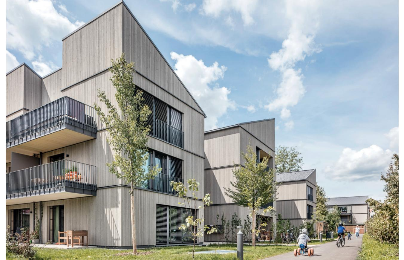
Die zinnenartig geneigten Pultdächer tragen zu einem lebendigen Erscheinungsbild bei. In dieselbe Kerbe schlägt die Fassade mit ihren fünf unterschiedlichen Lamellenbreiten. Sie wurde samt Fenstern und Absturzsicherungen bereits werkseitig montiert und die Außenwände just in time auf die Baustelle geliefert.
