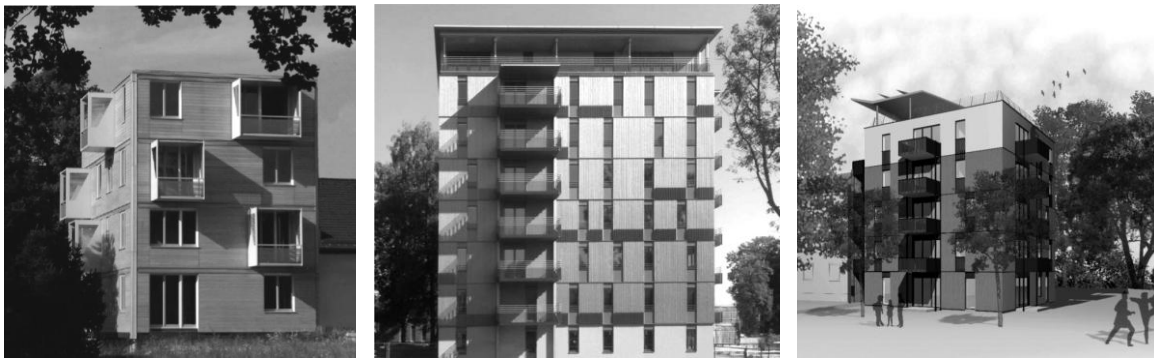
Abbildung 11: Entwicklung des Bausystems vom reinen Holzbau zum Holz-Beton-Hybridbau
