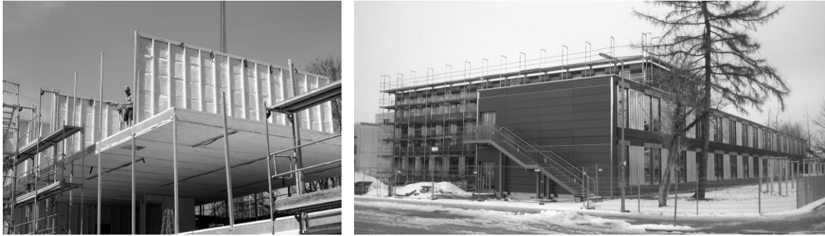
Abbildung 10: Baustelle Erweiterung Michaeli Gymnasium
