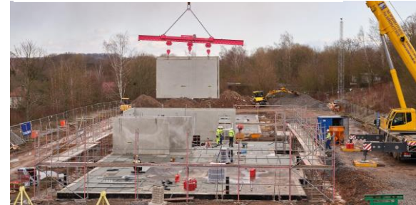
Baustelle Nordhausen Ende Januar
