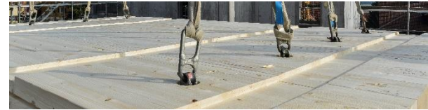
Mehrgenerationenhaus in Dietwil (CH) 4 Geschosse mit HBV-Decken
