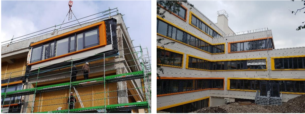
Abbildung 9: Sanierung Gymnasium Weilheim
