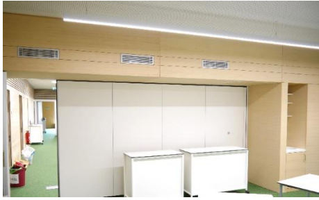
Abbildung 1: Lüftungsinstallation in der Schrankzone – Grundschule Pullach
