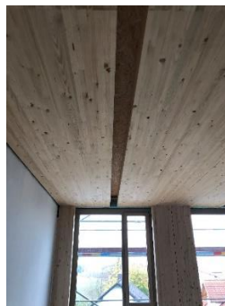
Abbildung 2: Lüftungsleitung in Ebene der Holz-Beton-Verbunddecke – Grundschule Oberding
