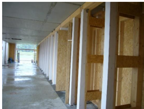
Abbildung 3: Installationszone zwischen Flur und Klassenraum – Grünes Zentrum Kaufbeuren
