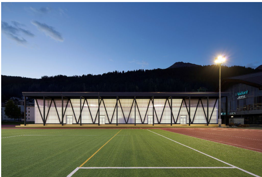
Abbildung 1: Trainingshalle HCD Foto: Fazun AG Architekten Ingenieure Berater
