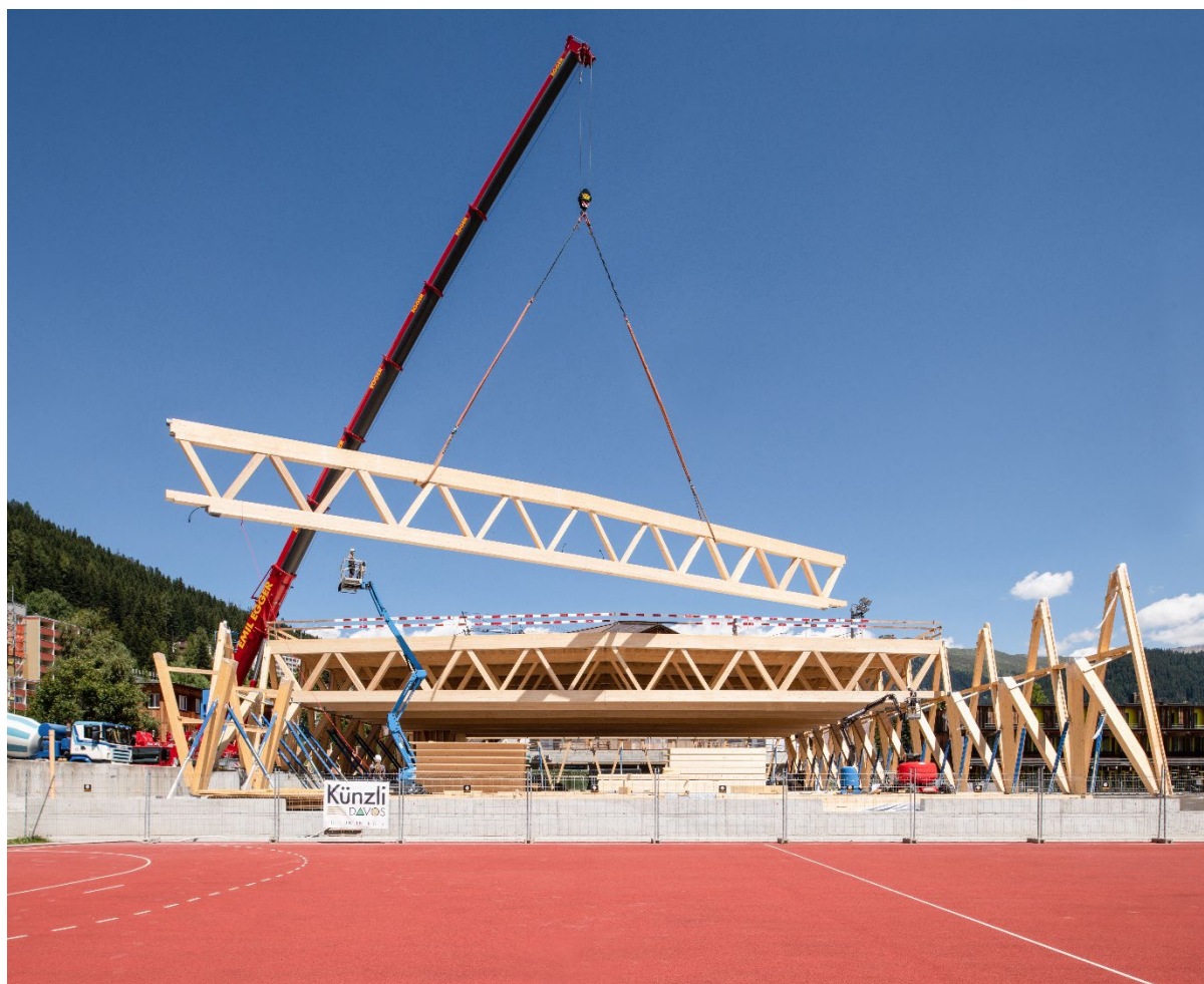
Abbildung 7: Fachwerkmontage Foto Künzli Holz AG
