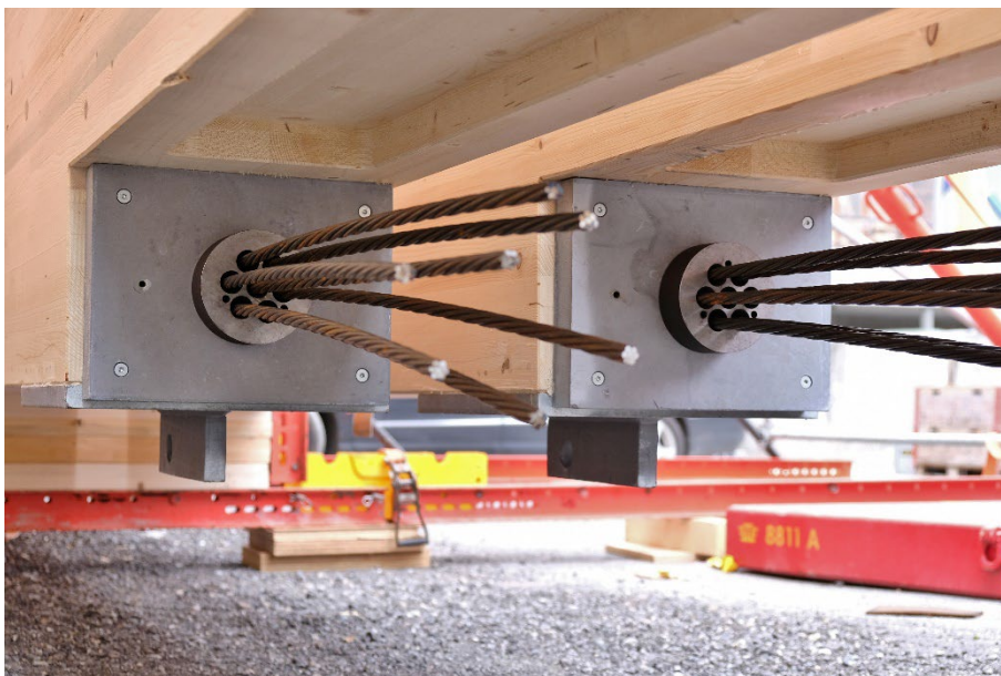
Abbildung 6: Verankerung Stahl-Litzen Foto Künzli Holz AG
