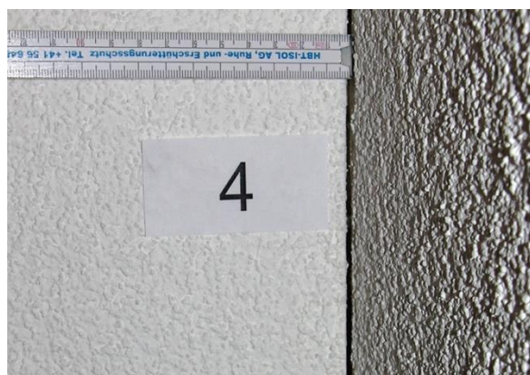
Abbildung 9: Innenecke mit geöffneter Fuge
