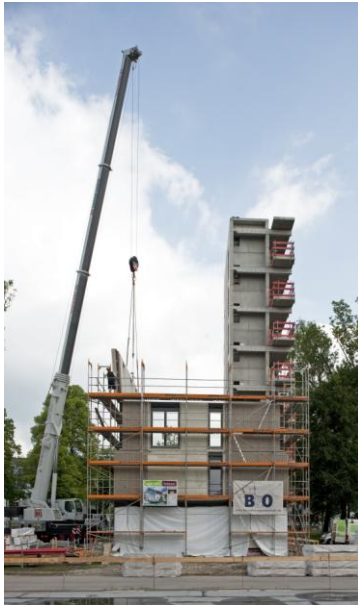
Abb. 8+9: Montage der Holzbauteile – jeden 2. Tag ein Geschoss
