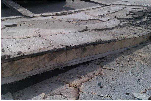
Abb. 3: Holzmassivwand nach Brandprüfung an der MFPA Leipzig
