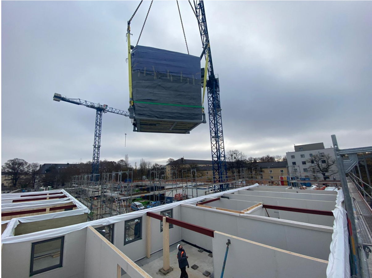
Abbildung 6: Wohnen am Dantebad II, Einbau der Fertigbäder; Quelle: B&O Bau
