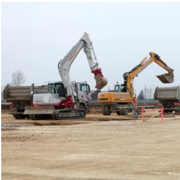
Die Baustelle im November 2010
