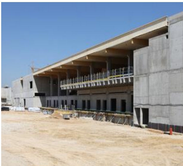
Die Baustelle im Mai 2011
