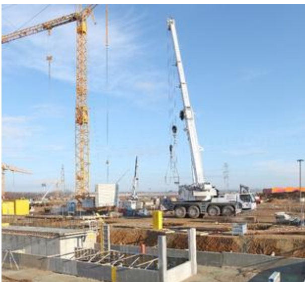
Die Baustelle im Februar 2011
