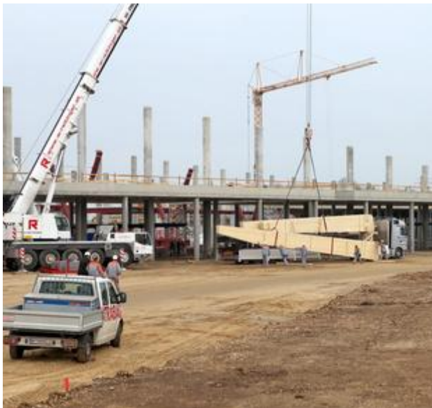
Die Baustelle im April 2011
