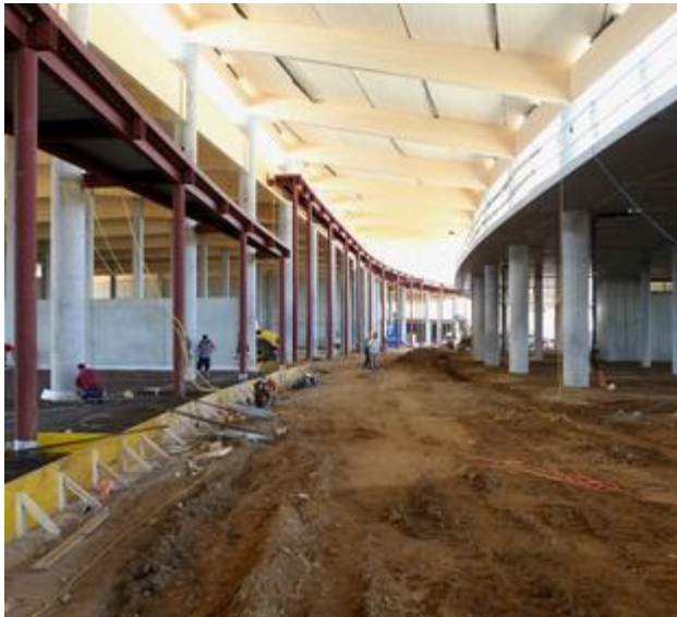
Die Baustelle im Juni 2011
