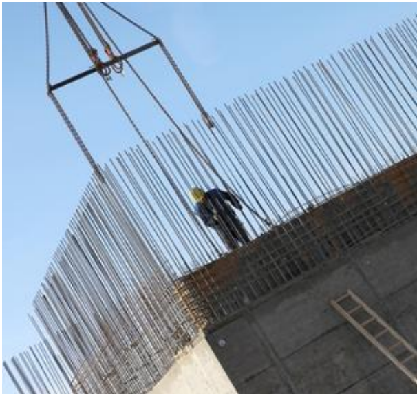
Die Baustelle im Jänner 2011
