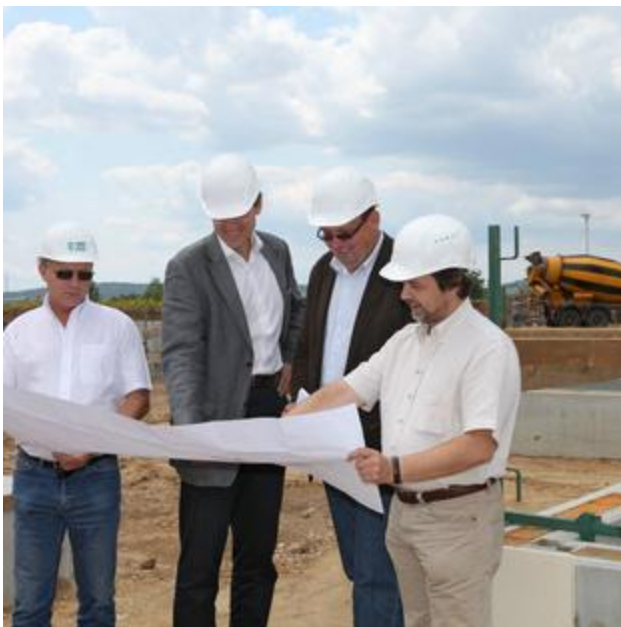
Baubeginn für Biomasseheizwerk
