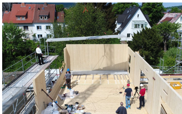
Abbildung 7: Pilotanwendung der geklebten HBV-Bauweise in einem Schul-Neubau in Kassel
