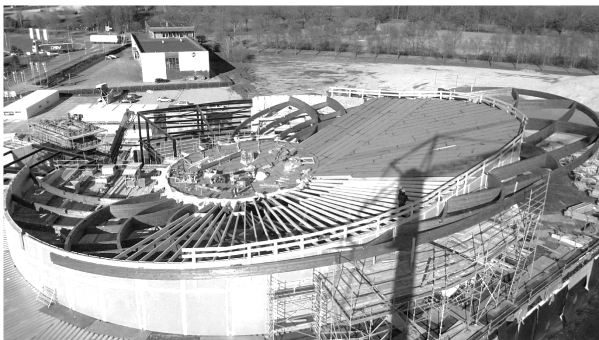
Abbildung 8: Blick über das Dach. Auf der rechten Seite ist die Dachabdichtung bereits montiert.
