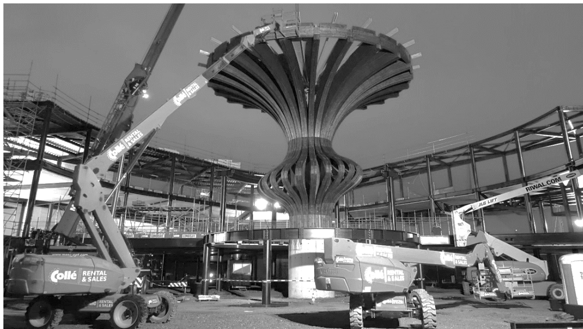
Abbildung 7: Montage vom Stamm
