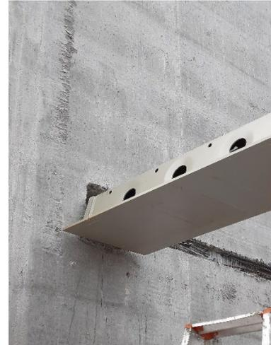
Abbildung 8+9: Links: Schnitt Deltabeam-Träger; Rechts: Anschluss Deltabeam-Träger an Treppenhaukern
