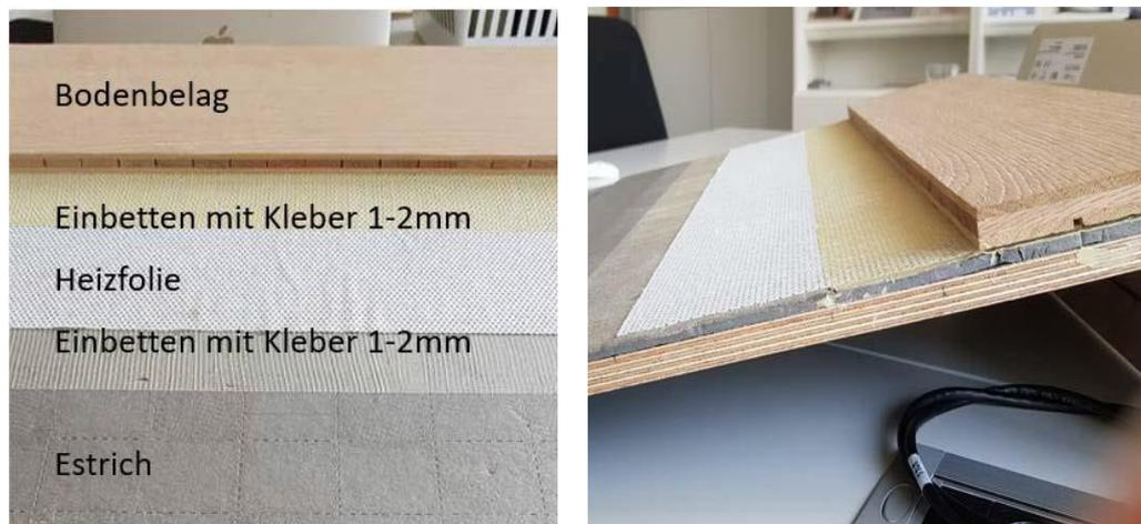
Abbildung 5: Aufbau der Fußbodenheizung mit Heizmatten aus Carbon-Kunststoff-Verbundmaterial
