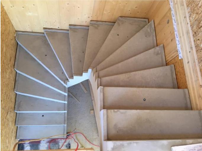
Abbildung 2: Innentreppe als Stahlbetonfertigteile
