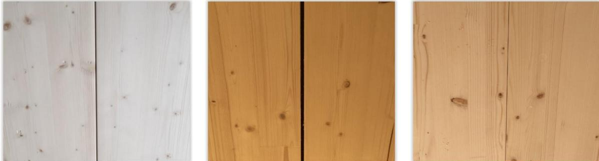
Abbildung 7: Drei Ausführungsvarianten der Brettschichtholzdecken in Sichtqualität
