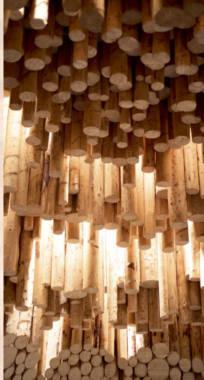
► Die Anordnung und die unterschiedliche Länge der Stämme prägen die Lichtführung
