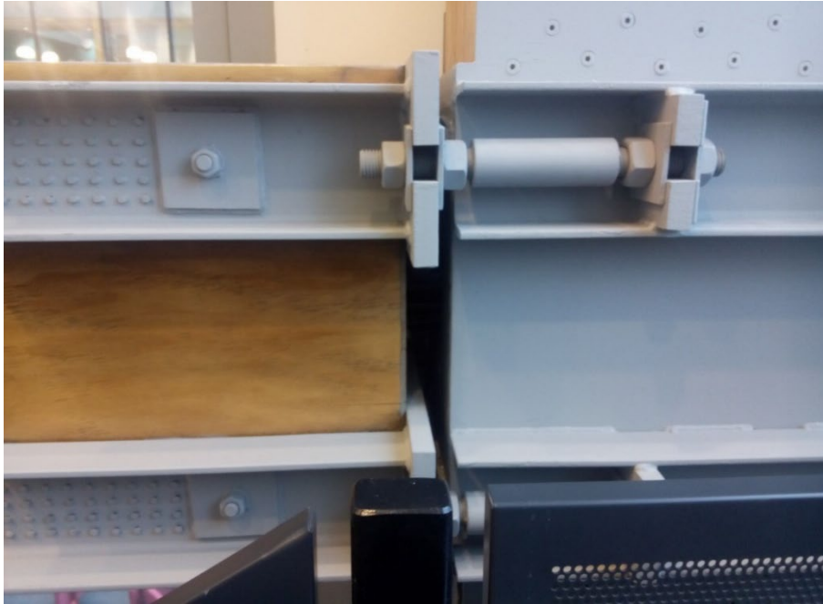
Abbildung 3: Dissipative Gewindestange im Trimble Navigations Hauptsitz, Ötautahi Christchurch, Aotearoa Neuseeland.
