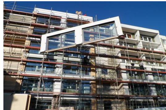
Abbildung 3: Vorfertigung von Holzrahmenbauelementen mit kompletter Bekleidung - Montage der Fassadenelemente Quelle: Lattkearchitekten
