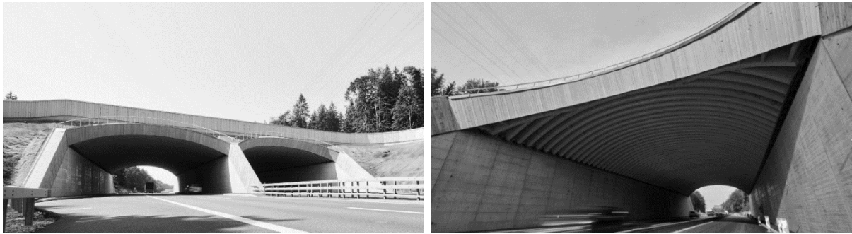
Abbildung 2: Fotos der fertiggestellten Brücke
