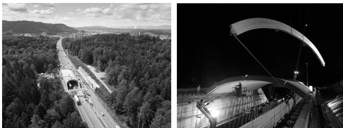
Abbildung 8: Montage der einzelnen Binder zwischen die Portalmodule.
