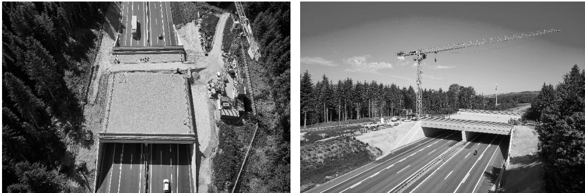
Abbildung 9: Montage der einzelnen Binder zwischen die Portalmodule. Bilder: Astra
