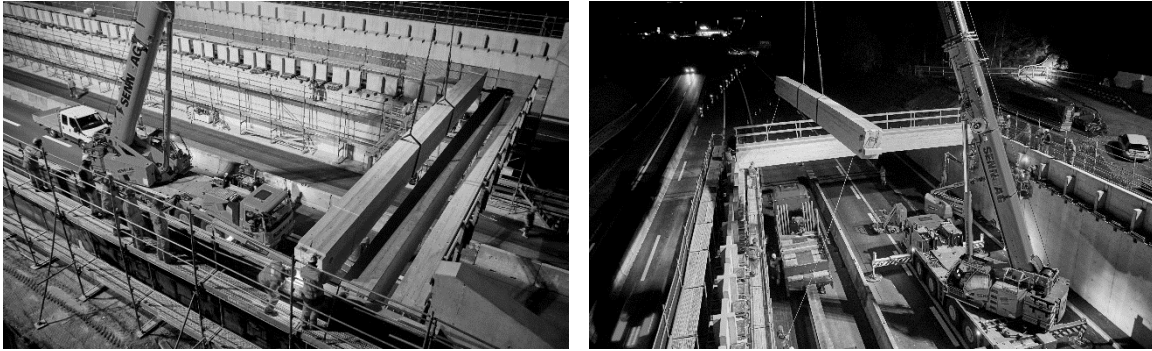
Abbildung 14: Montage eines Trägers, Bilder: Astra
