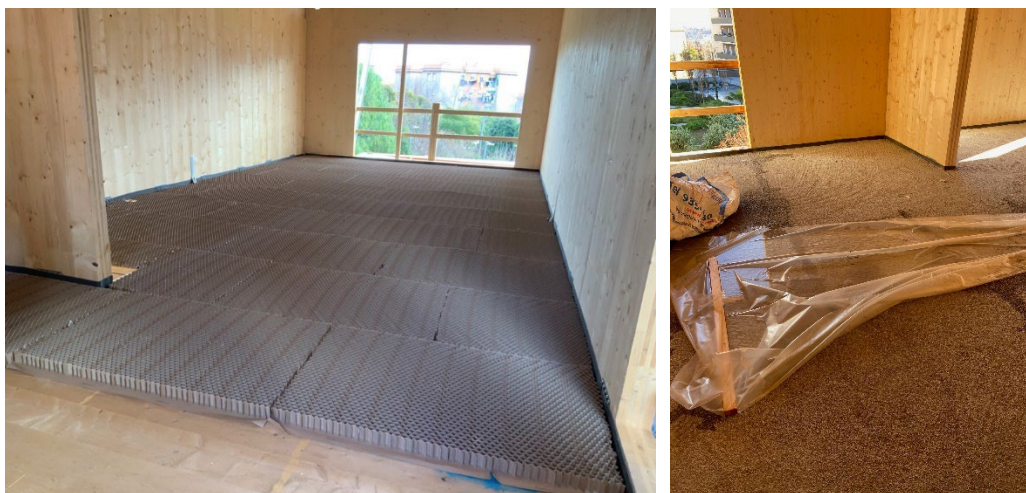
Ilustración 5: solera seca en fase de construcción edificio 1
