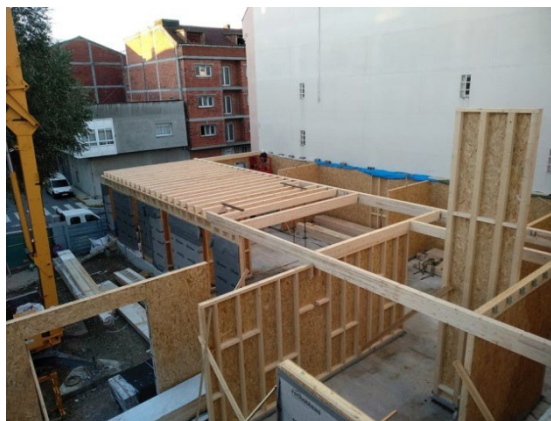
Figura 2: Montaje de muros portantes y forjados
