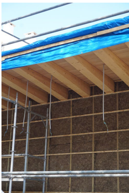
Figura 5: Cerramiento exterior preparado para recibir el entablado de madera
