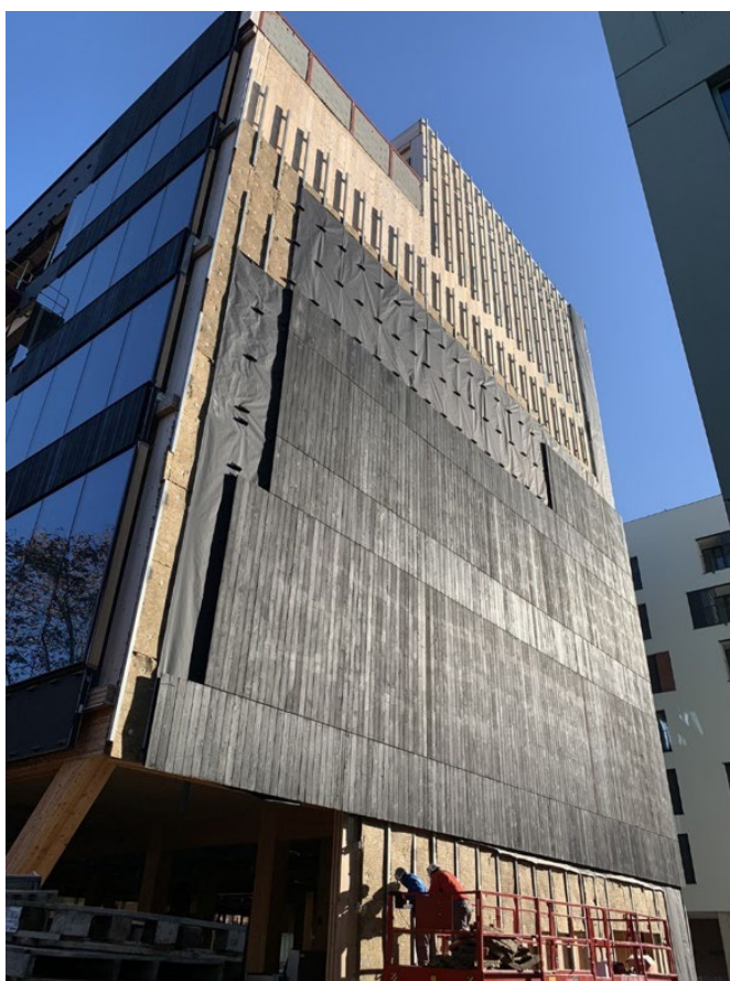
Ilustración 15: Montaje de la fachada medianera revestida en madera carbonizada
