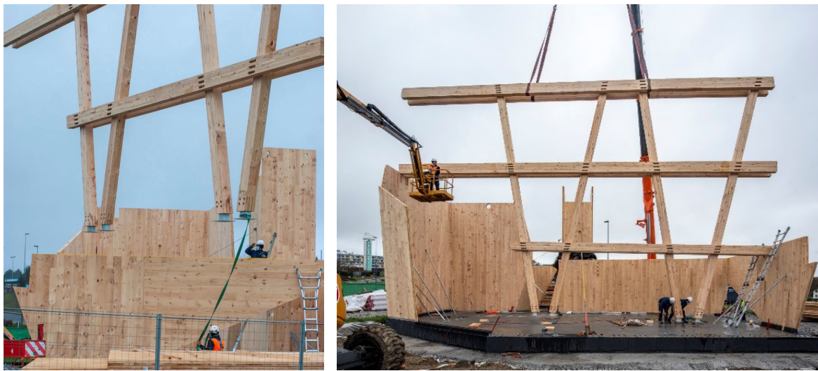
Ilustración 10: Colocación del pórtico mediante izado del mismo (fotografías: Héctor Santos-Díez)
