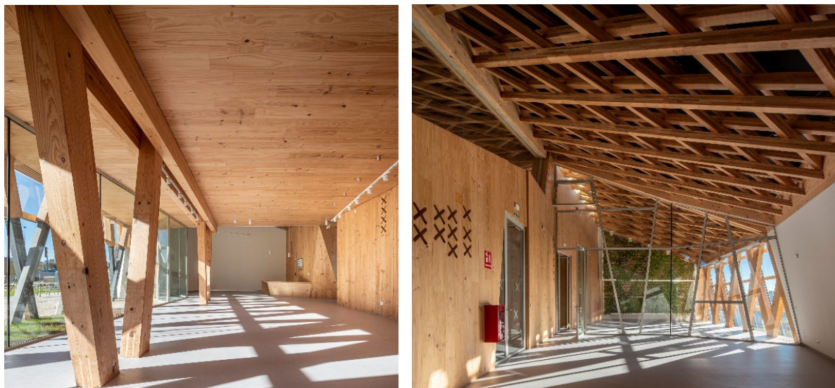
Ilustración 14: Planta baja (izq.), con todos los elementos estructurales de Pinus radiata (izq.) y planta de cubierta (dcha.), con las celosías multicapa de Eucalyptus globulus (fotografías: Héctor Santos-Díez)
