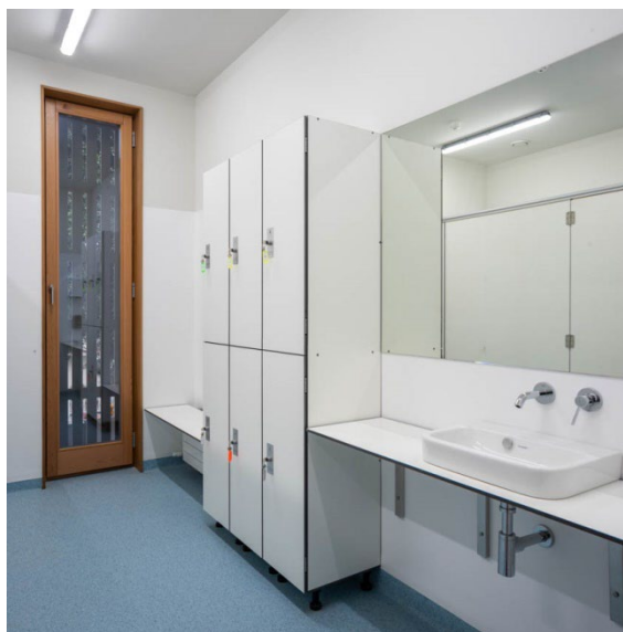
Figura 11: Tablero melaminado en vestuarios
