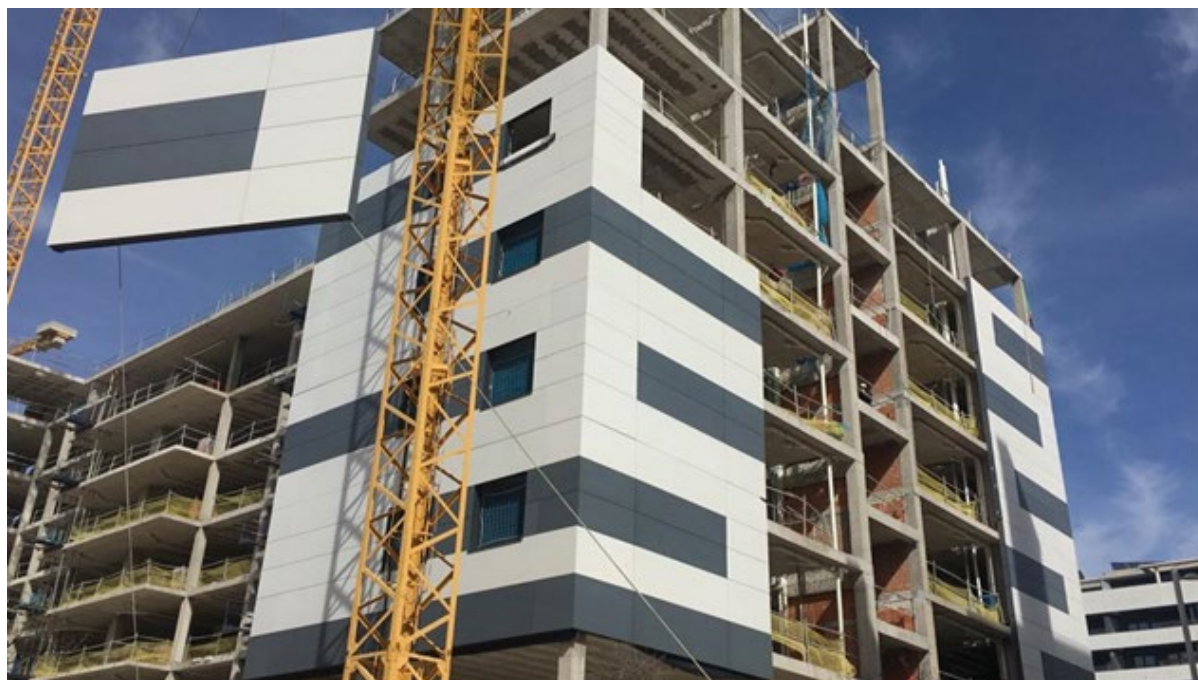
73 viviendas en Cañaveral
