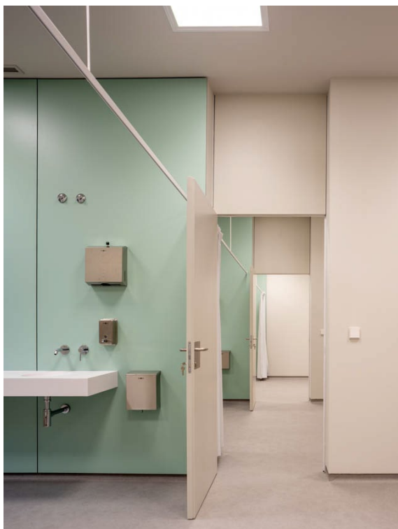
Figura 10: Tablero melaminado tras los lavabos de las consultas
