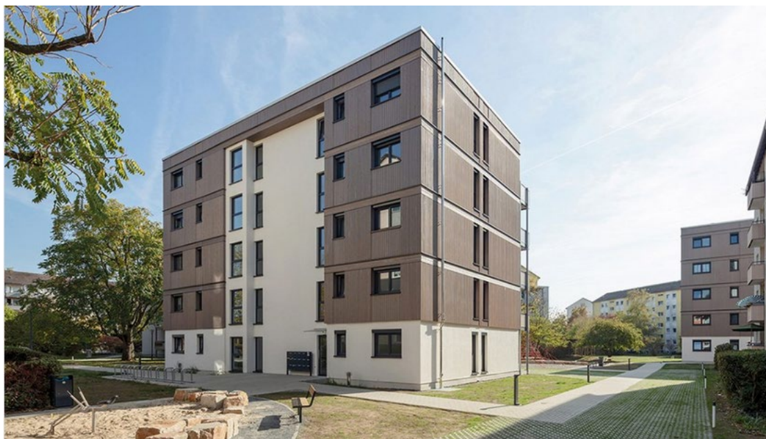
Ilustración: Construcción con módulos en el proyecto residencial Hans-Geiger en Erlangen, constructora Dawonia
