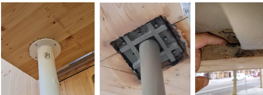
Ilustración 18: colocación de pilar con placa. En la izquierda, placa circular sobre forjado (refuerzo a «punzonamiento» con tornillos a 45°, que venían de taller); colocación a posteriori de placa de reparto, recortando CLT para su alojamiento (se produce separación de láminas del forjado – delaminación)
