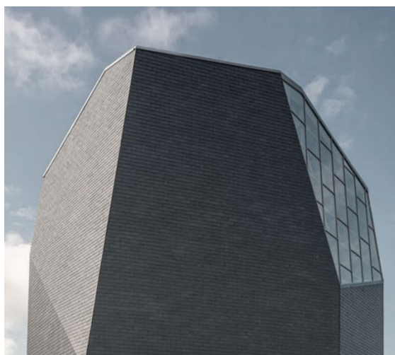
Ilustración 9: Fachada ventilada de pizarra. Detalle durante el montaje (izq.) y aspecto exterior del edificio una vez terminada su colocación (dcha.) (fotografías: Héctor Santos-Díez)
