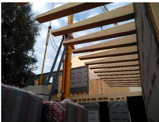
Figura 4: Montaje cerramiento planta primera
