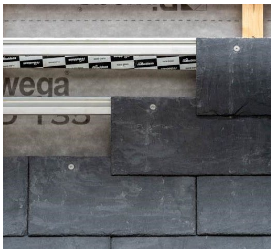
Ilustración 9: Fachada ventilada de pizarra. Detalle durante el montaje (izq.) y aspecto exterior del edificio una vez terminada su colocación (dcha.) (fotografías: Héctor Santos-Díez)
