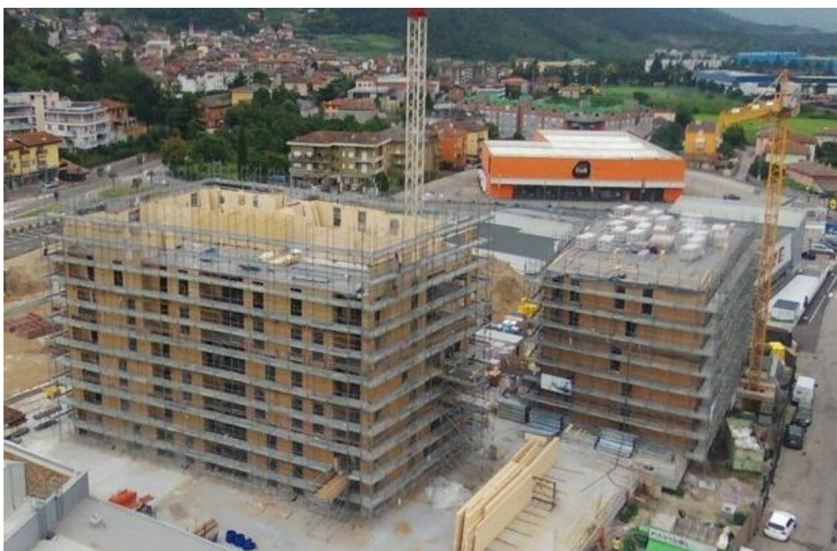
Fotos de obra durante el montaje del contralaminado
