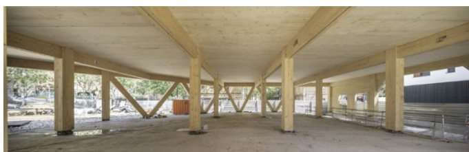
Ilustración 12: Arranque de la estructura en planta baja, sobre losa de hormigón
