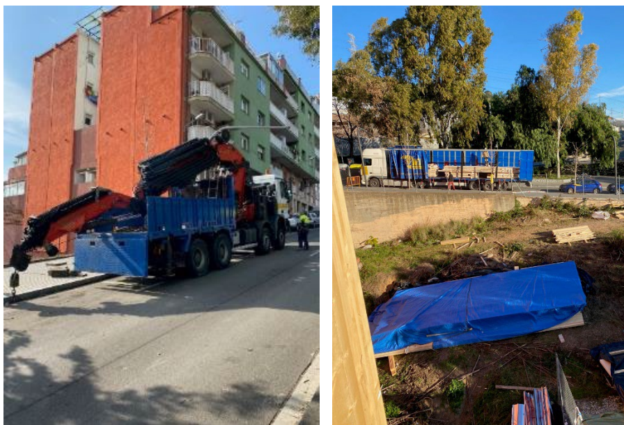
Ilustración 12: A la izquierda, grúa pluma utilizada finalmente; a la derecha, vista de la calle posterior desde donde se descargaba el material.
