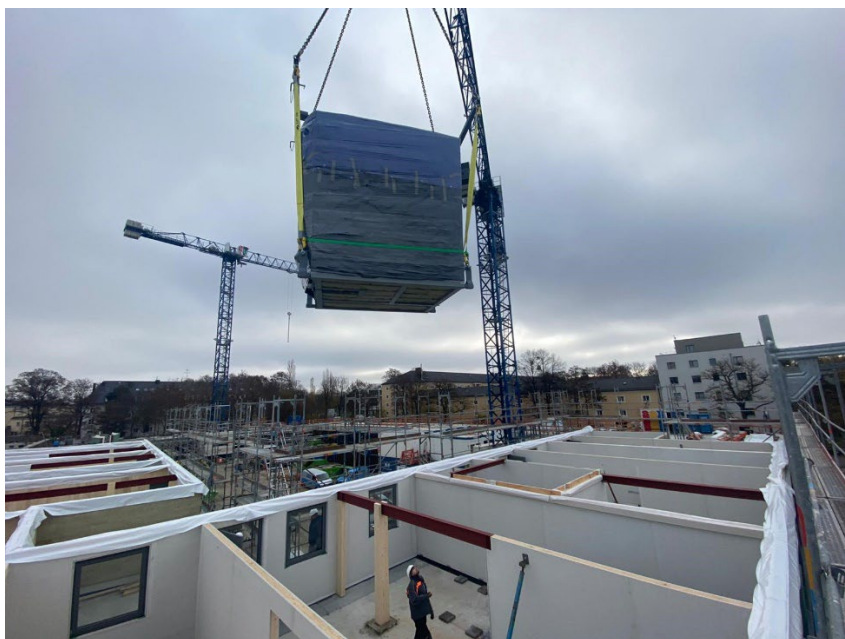
Ilustración: Construcción modular B&O, montaje de los baños prefabricados; fuente: B&O Construcciones
