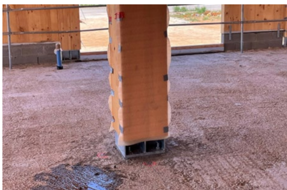
Ilustración 4: Arranque metálico de pilar sobre forjado de hormigón
