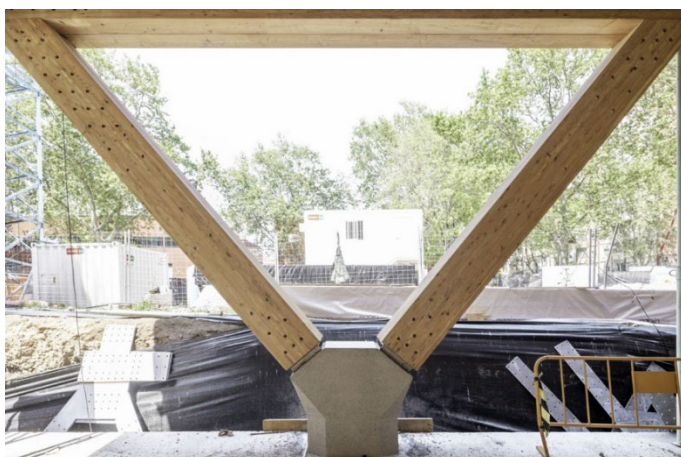
Ilustración 13: Dado de hormigón de arranque de los pilares en V en el exterior
