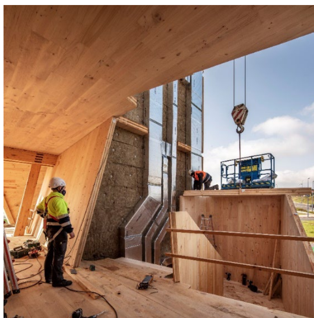
Ilustración 12: Muro técnico equipado con instalación de ventilación. Concepto constructivo (izq.) y vista durante el montaje (dcha.) (fotografía: Héctor Santos-Díez)
