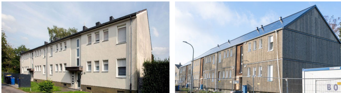
Ilustraciones: proyecto en Mönchengladbach, rehabilitación con elementos prefabricados de fachada en madera: Antes-después, constructora: LEG
