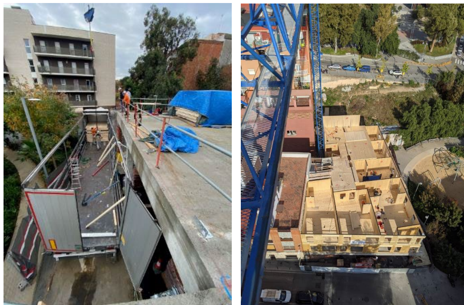
Ilustración 11: A la izquierda, ubicación del camión para descarga; a la derecha, posición de la grúa respecto al edificio.
