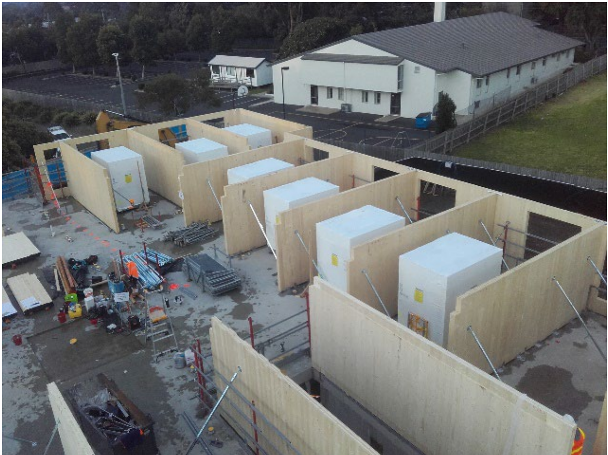
Fotos de obra durante el montaje del contralaminado
