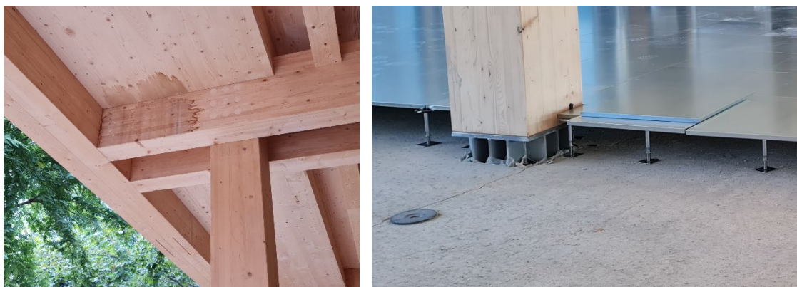
Ilustración 7: la solera seca se cambió en obra por motivos económicos, por mortero (solución húmeda)
