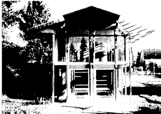
Abb. 6: Wohnhaus in Pullach (D) Integration von aktiver und passiver Energieeinsparung (Speicherwand und transparente Wärmedämmelemente).(Arch.: Th. Herzog, M. Volz)*
