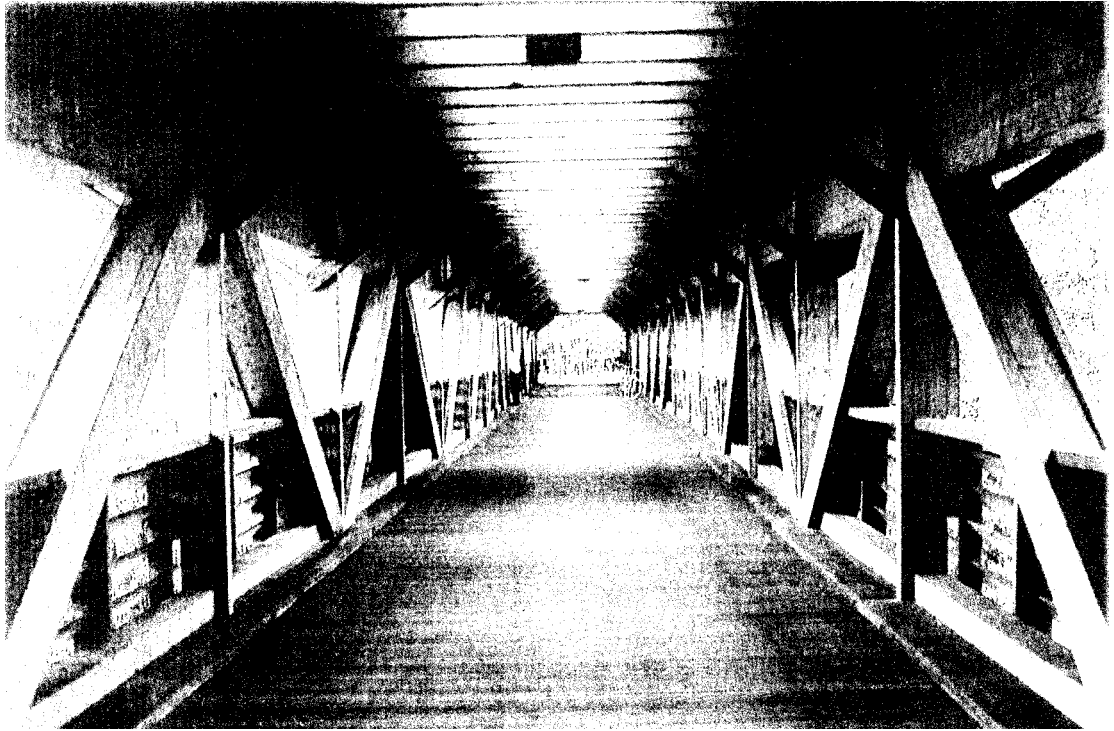
Abb. 5: Brücke über die Simme, Wimmis bei Thun (CH), als Beispiel modernen landschaftsgebundenen Bauens mit Brettschichtholz (Ingenieurgemeinschaft Natterer, Gärtl)*
