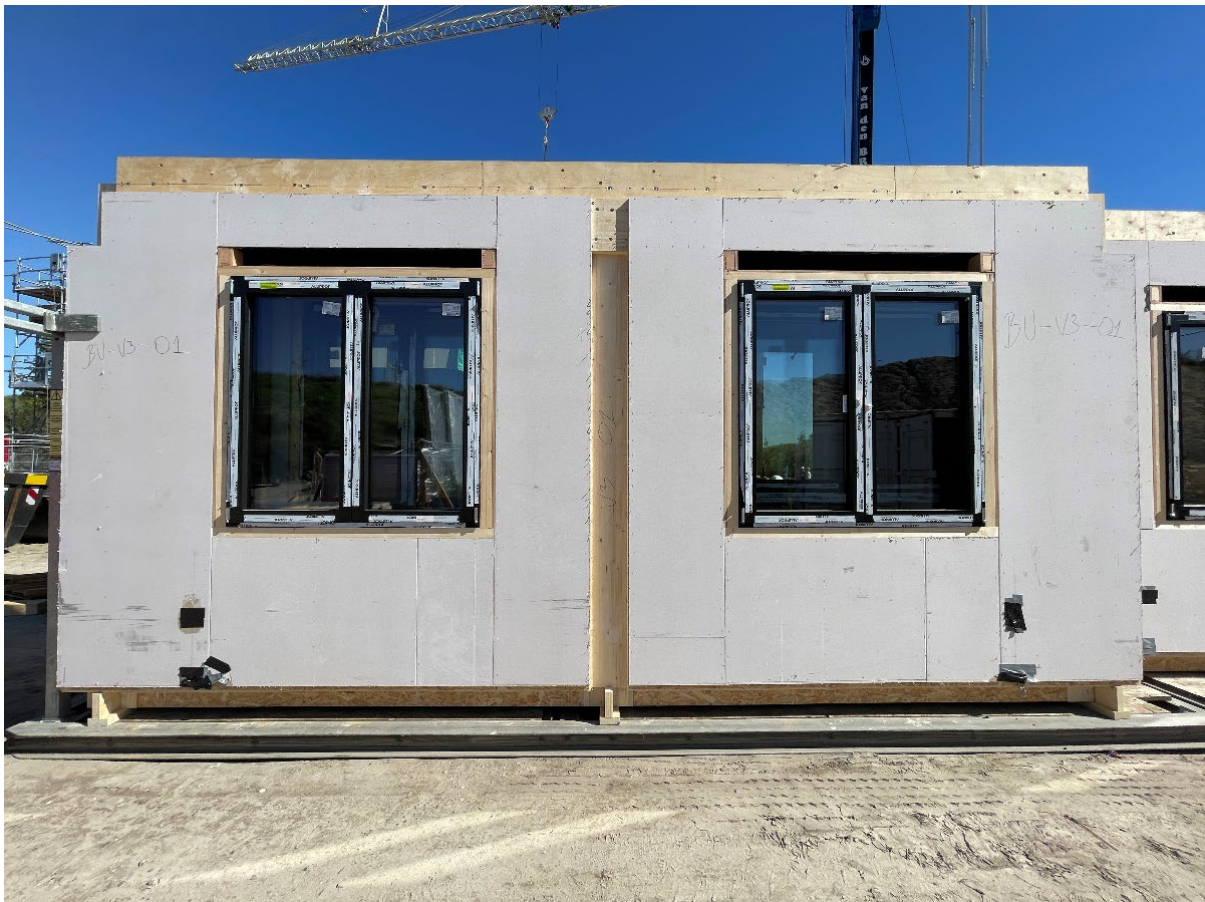
Abbildung 6: Für die Fassade kommt ein Skelett-Rahmenbau aus Brettschichtholzstützen und Furnierschicht-holzrandträgern zum Einsatz, die Außenwände werden als Holztafelbau realisiert.
