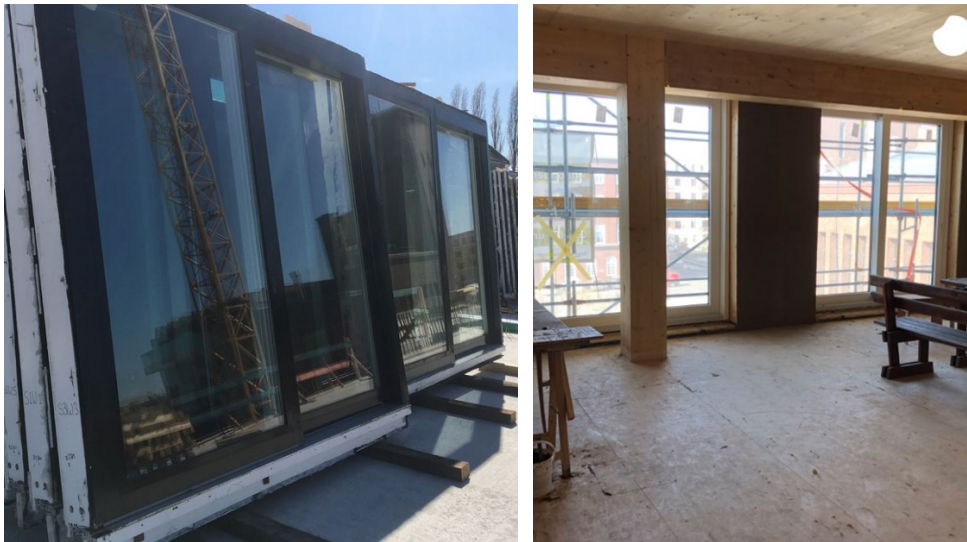
Abbildung 16: demontierte und wieder eingebaute Fenster
