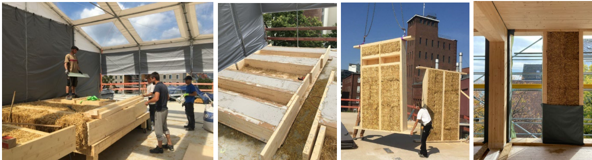
Abbildungen 21: Vorproduktion und Montage der Strohballenwand
