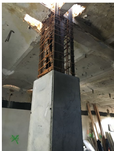
Abbildung 5: alter Stahl / neuer Beton
