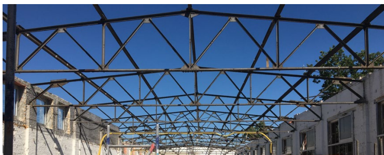
Abbildung 14: Demontage Dachtragwerk
