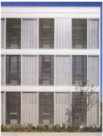
Gußglas mit transparenter Wärmedämmung
