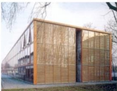
Klarglas mit gedämmten Holzpaneelen
