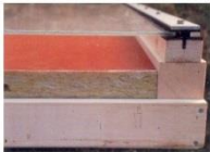
Aufbau Solarfassadenelement
