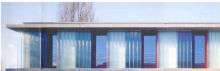
Gußglas mit und ohne Dämmung
