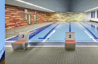
Bauen im Bestand Technische Betriebe, Remscheid
