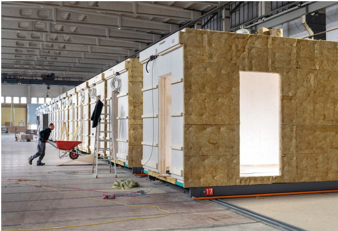
Abbildung 5: Vorfertigung im Werk © Kaufmann Bausysteme
