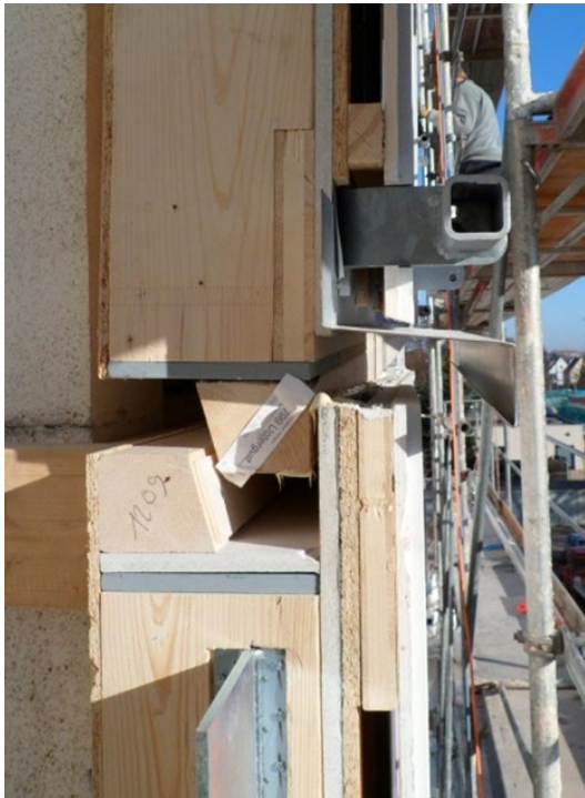
Abbildung 8: vertikaler Elementstoß
