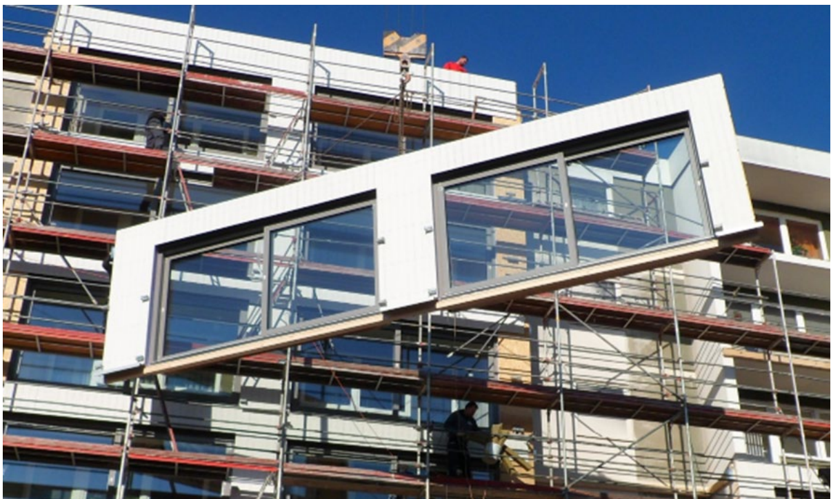
Abbildung 5: Montage TES Element
