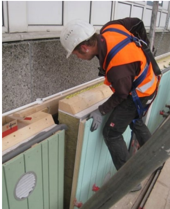
Abbildung. 9: horizontaler Elementstoß
