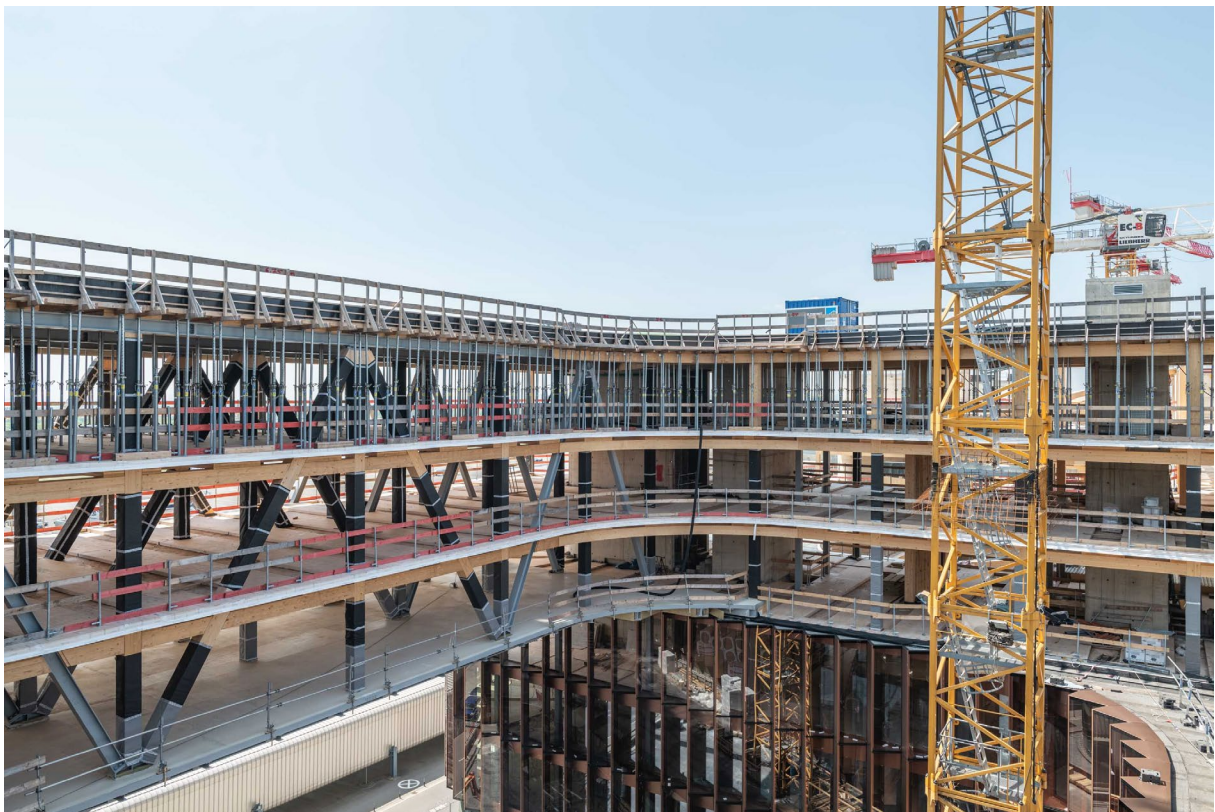
Abbildung 7: Außenrandbegrenzungen durch Absturzsicherungsgeländer (© Thomas Urbany)
