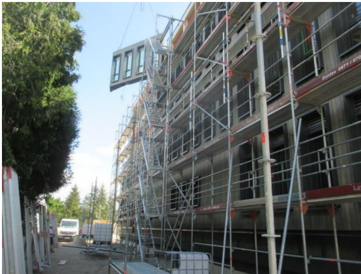
Abbildung 10: Baustellenfoto Montage Fassadenelemente
