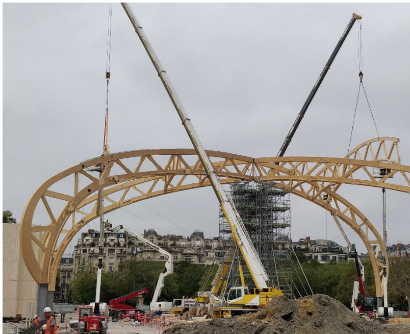
Bild 8: Montage der Portale an der Kreuzung mit Traggerüstturm.
