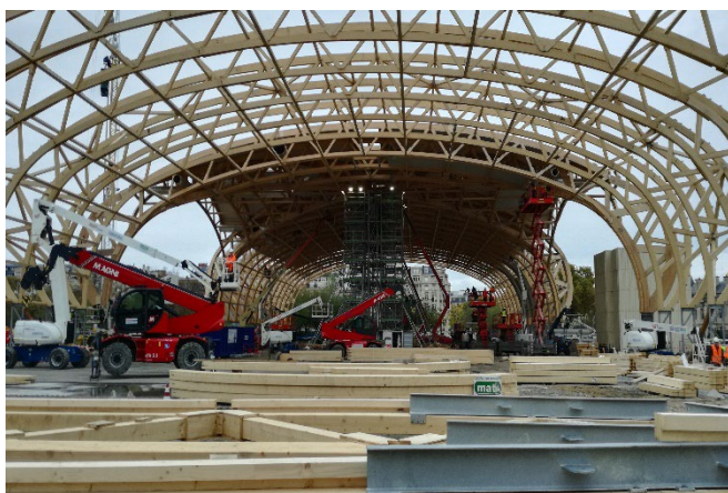
Bild 9: Fortschritt Ende Oktober 2020
