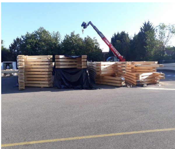
Bild 6 und 7: Vormontage in Muttersholtz und Beladung von Fachwerkabschnitten.
