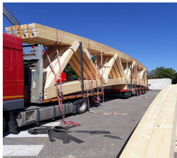
Bild 6 und 7: Vormontage in Muttersholtz und Beladung von Fachwerkabschnitten.
