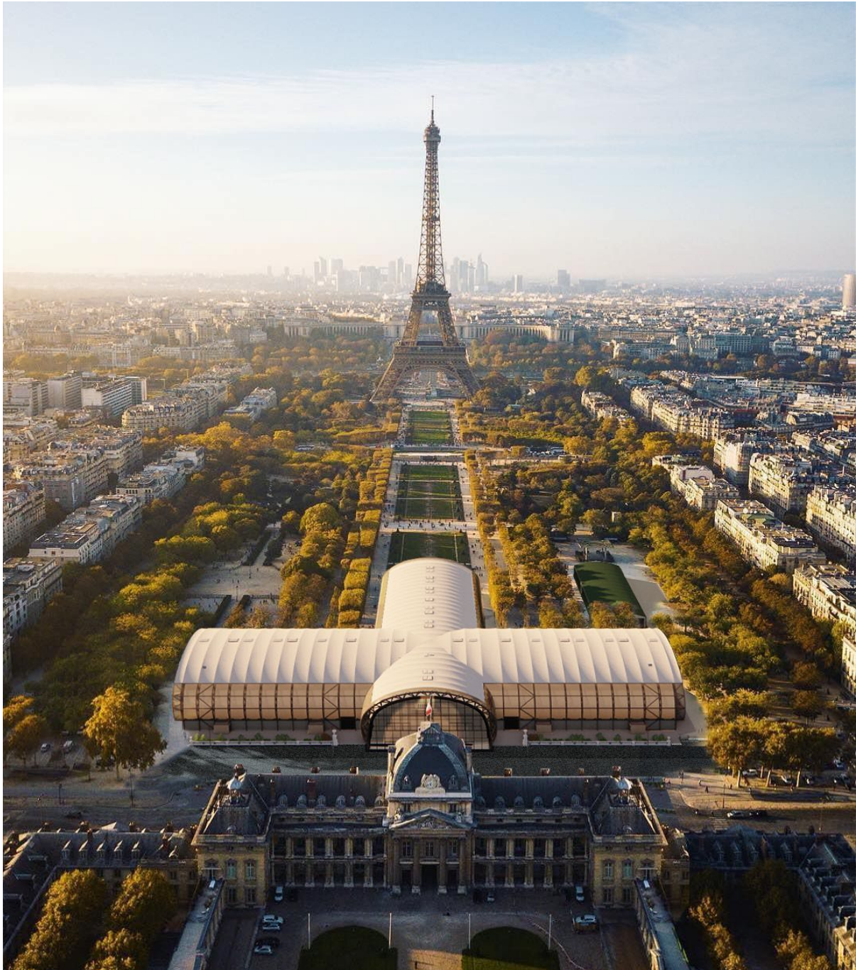
Bild 11 : Das fertige Gebäude.
