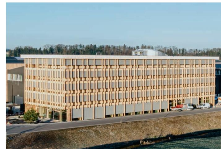
Das Bürogebäude «Stammhaus» mit umlaufenden Balkonen und vorgehängter Fassade aus vertikalen Holzslisenen.
