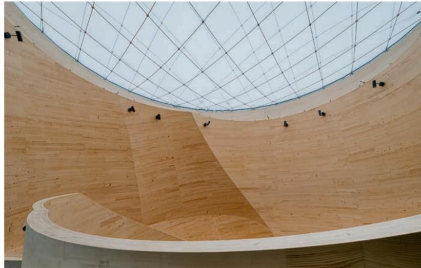
Das Oberlicht als Leichtkonstruktion mit ETFE-Folienkissen sorgt für Helligkeit im Atrium.
