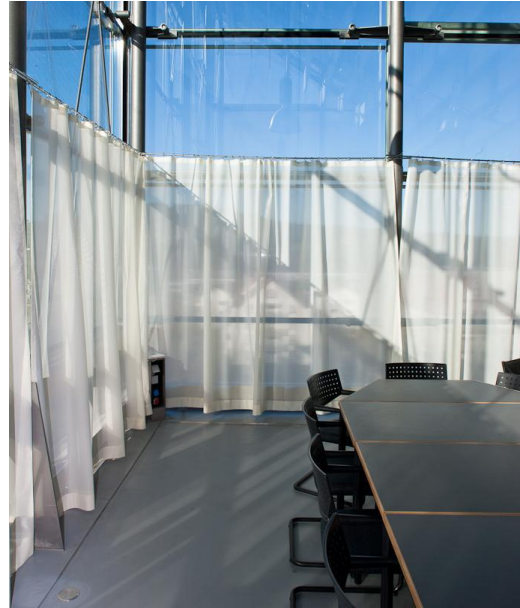
Abbildung 4: Schallabsorbierende, lichtdurchlässige Vorhänge in einer Probeinstallation für akustische Messungen an der Empa (Quelle: Weisbrod-Zürcher, Schweiz)
