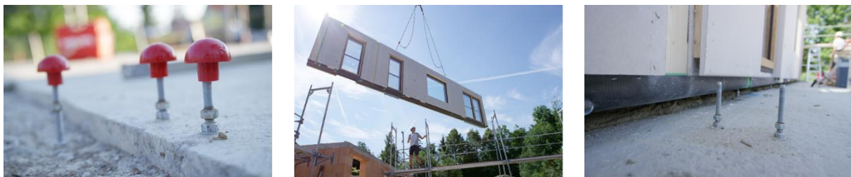
Abbildung 14: Absetzen eines Wandelementes auf die vorbereitete Bodenplatte
