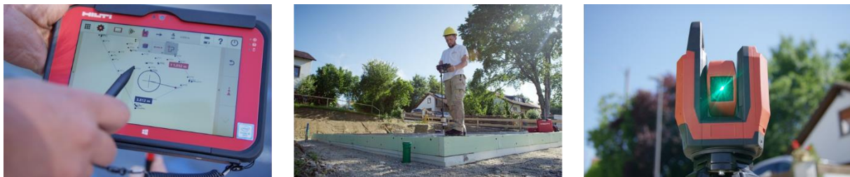
Abbildung 11: Verbindungspunkte auf dem Tablet und Anfahren der Bohrungspunkte
