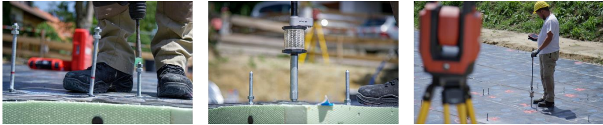
Abbildung 13: Nivellierung der Befestigungspunkte über zweite Mutter und Referenzpunkt
