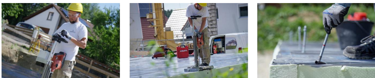
Abbildung 12: Anfahren und Bohren des Befestigungspunktes sowie Einstecken des mechanischen Dübels
