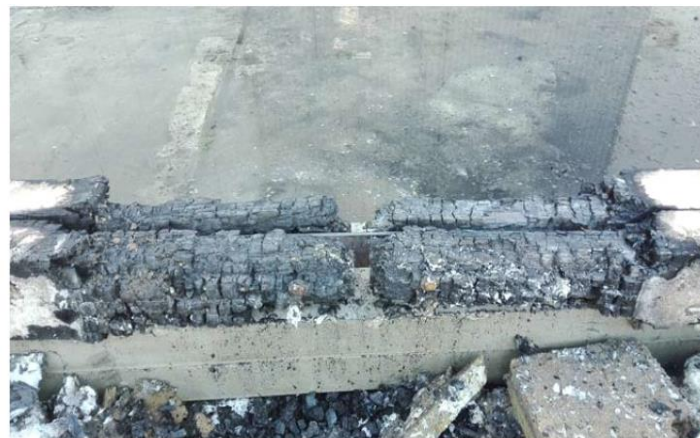
Figure A5.3 Campagne 1 – Configuration 1 – Assemblage après essai
