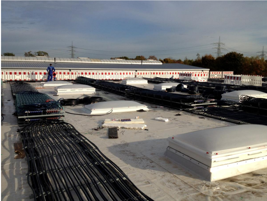
Abbildung 6: Beispiel eines Flachdachabsorbers während der Montage
