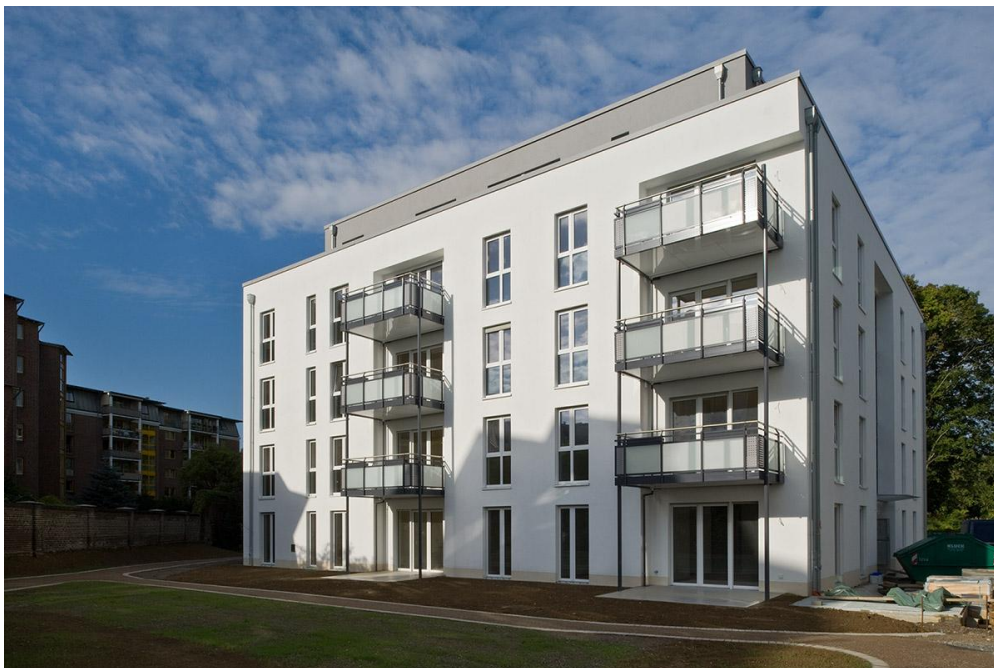
Abbildung 1: Eines der vier Gebäude
