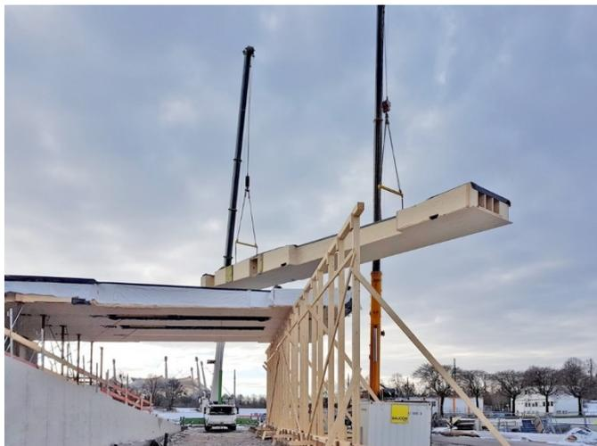
Abbildung 13: Montage Hohlkastenelemente
