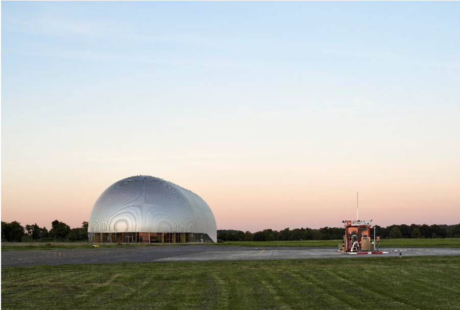
Abbildung 2: Die Aluminiumfassade legt sich wie ein Tuch über die Holzkonstruktion. Die Glasfuge lässt die Fassade nahezu schwebend erscheinen.
