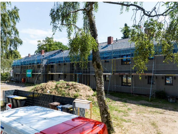
Abbildung 9: Saniertes Gebäude am Vossenbäumchen
