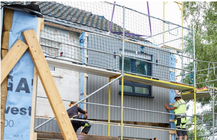
Abbildung 8: Montage Fassadenelement
