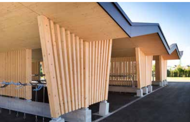
Holzfücher an den Enden und in den Mittelteilen akzentuieren die Konstruktion.
