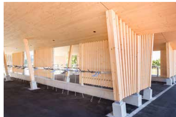
Jeweils vier dreiteilige Stützen tragen ein Dach.
