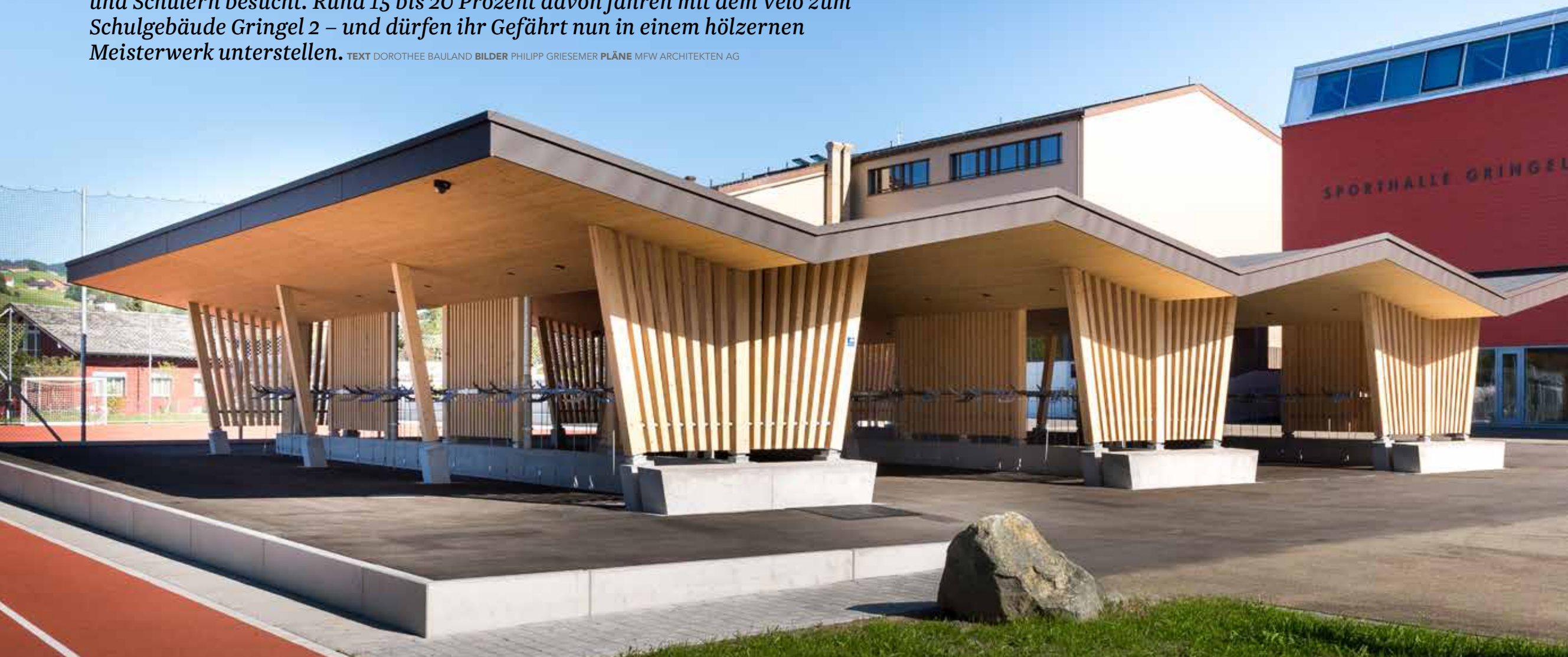
Auf dem Schulareal Gringel 2 in Appenzell nimmt der neue Unterstand rund 160 Velos auf.
