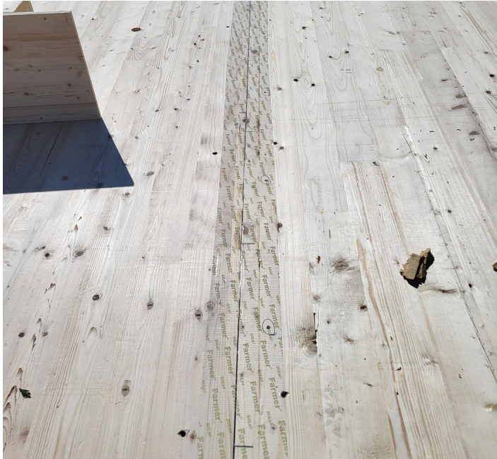
Abbildung 10: Abgeklebte TS3-Fuge
