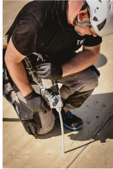
Abbildung 11: Vergiessen der TS3-Fugen durch die werksseitig erstellten Einfüllbohrungen.
