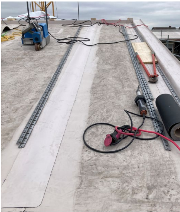
Abbildung 7: Dachbahn kombiniert alt / neu
