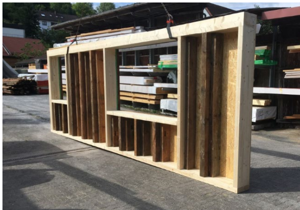
Abbildung 6: Außenwand mit neuem und recyceltem Holz
