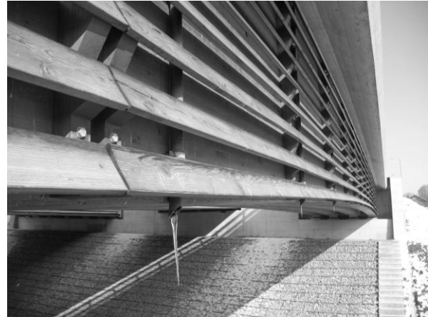
Abbildung 7: Gut einsehbare Hauptträger einer HBV-Brücke durch eine offene Stülpschalung
