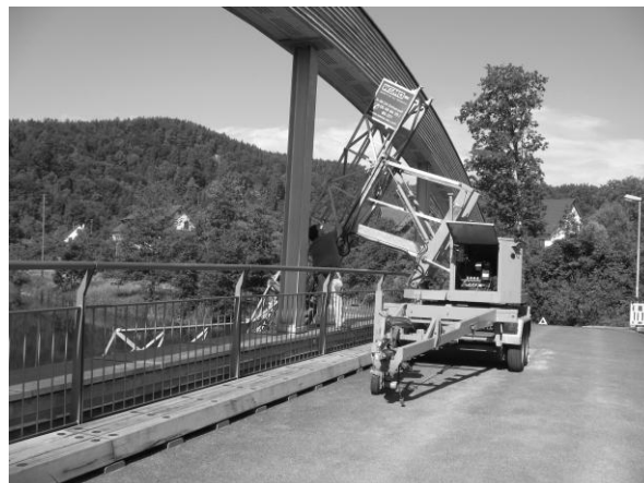
Abbildung 14: Brückenprüfung mit sehr handlichem Anhängergerät
