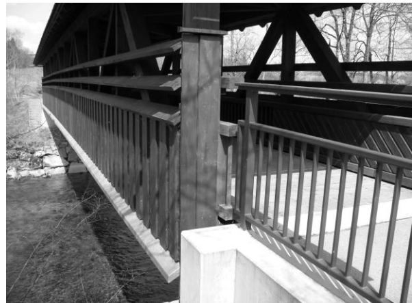
Abbildung 11: Weder mit Brückenuntersichtgerät noch mit Rollgerüst befahrbare, gut geschützte, überdachte Holzbrücke
