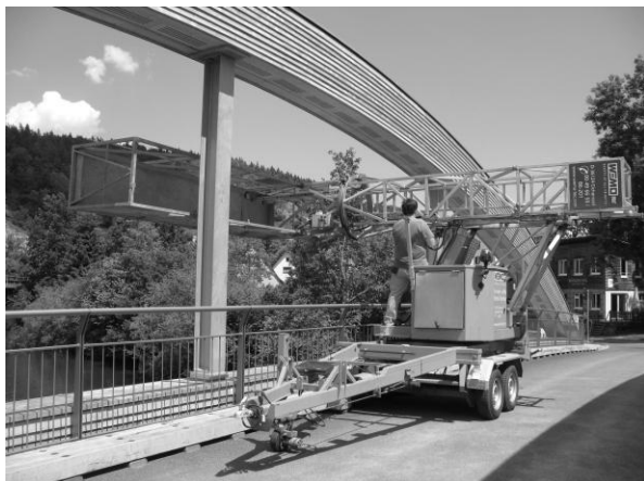
Abbildung 13: Brückenprüfung mit sehr handlichem Anhängergerät
