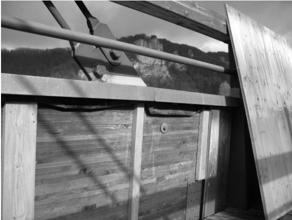
Abbildung 6: Beispiel einer gut entfernbaren, nachgerüsteten Schutzbekleidung
