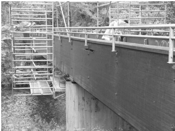
Abbildung 10: Mit Rollgerüst befahrene Trogbrücke
